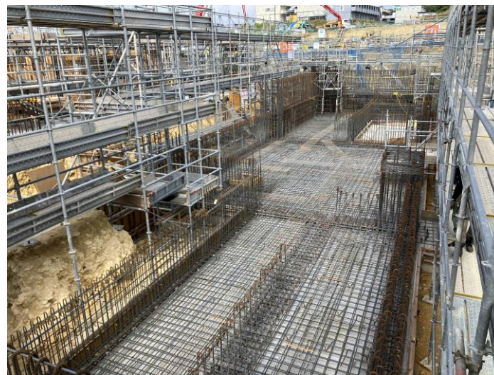
写真⑫(躯体工事 C棟 ピット階床配筋状況)
