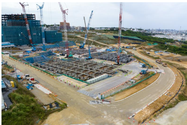
写真⑦(北北東側)
