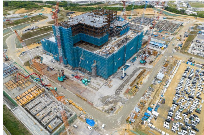
写真②(南南東側)
