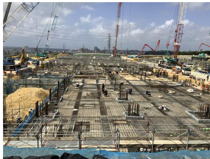
写真⑩(躯体工事 A棟 1階床配筋状況)
