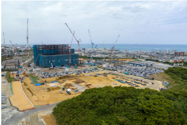
写真①(東南東側)
