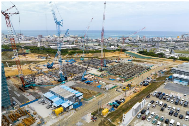
写真⑨(南東側)
