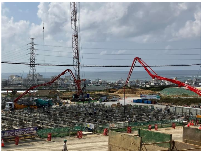
写真⑪(躯体工事 B棟 地中梁コンクリート打設状況)
