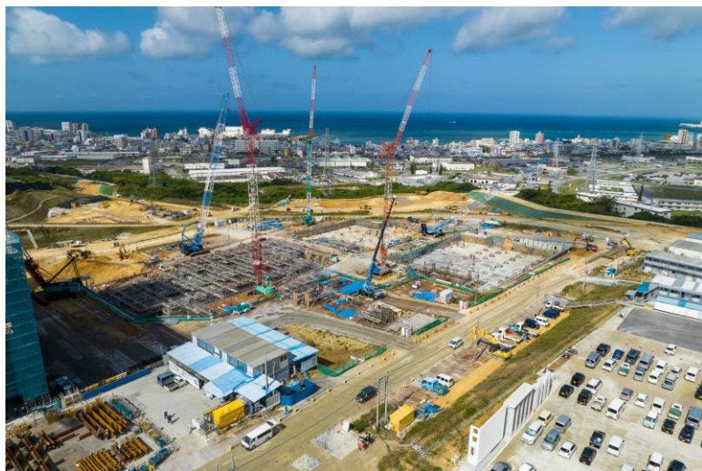
写真⑨(南東側)
