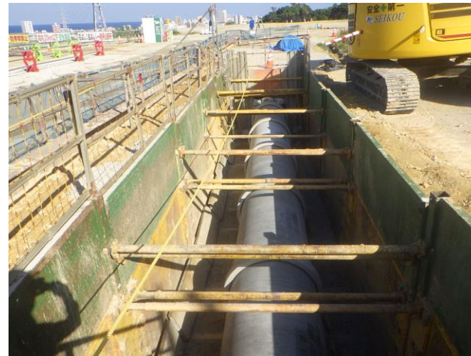
写真⑭(ホスピタルA棟 ニュー 雨水排水工事状況)
