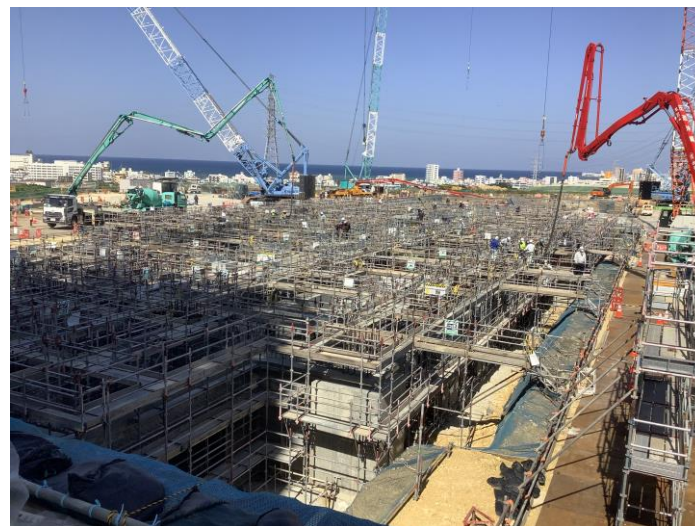
写真⑩(躯体工事 A棟 基礎・地中梁躯体工事状況)
