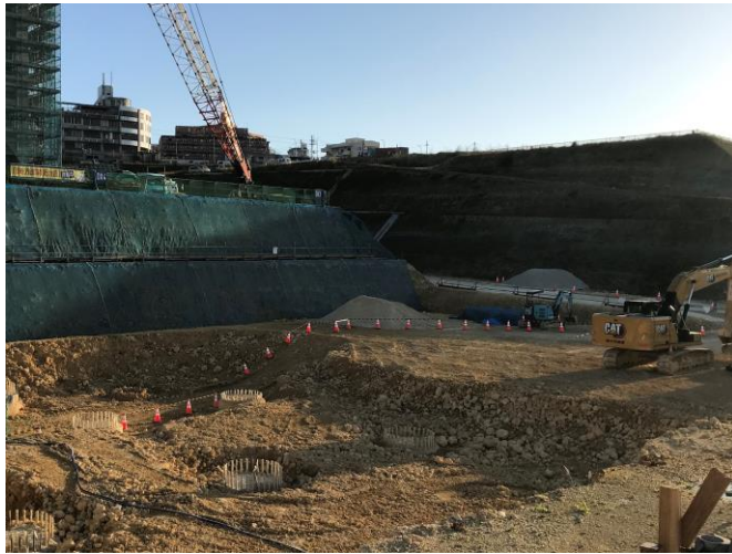
写真⑬(土工事 D棟 二次掘削状況)
