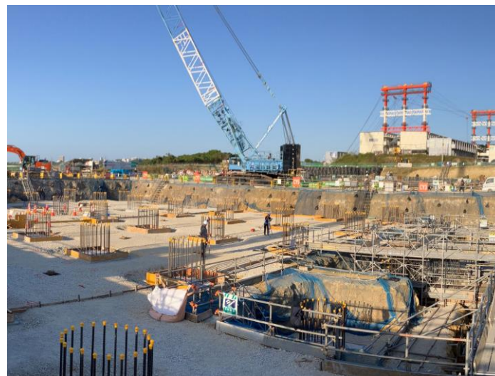
写真⑫ (躯体工事 C棟 基礎・地中梁躯体工事状況)
