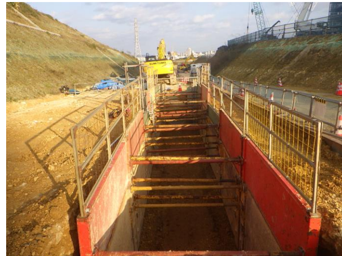
写真⑭(キャンパスペースニュー 雨水排水工事状況)
