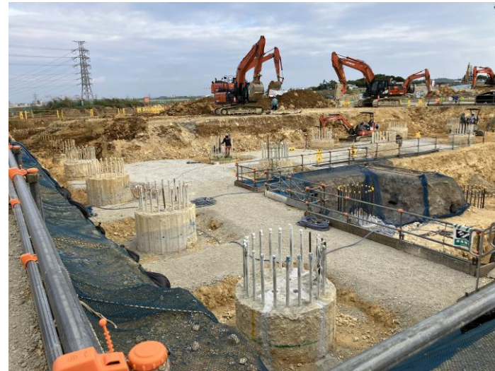
写真⑫(土工事 C棟 掘削状況)
