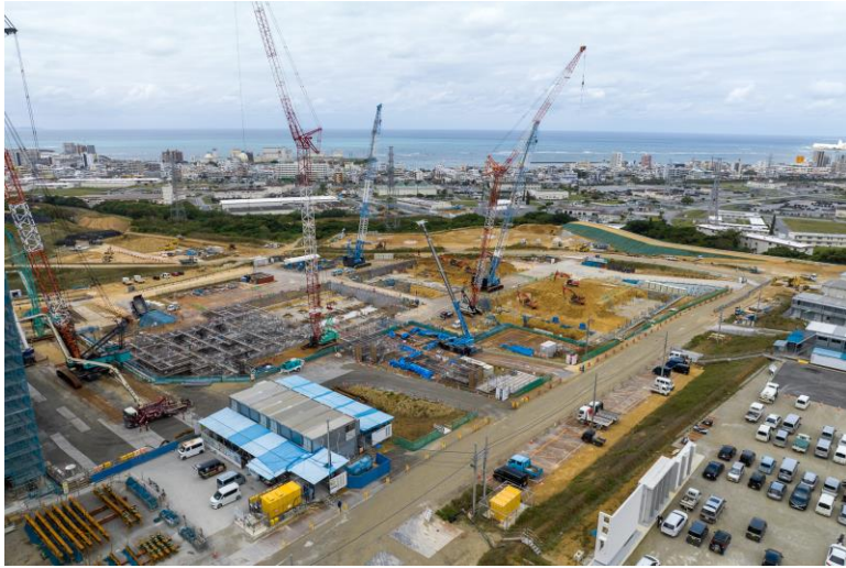
写真⑨(南東側)
