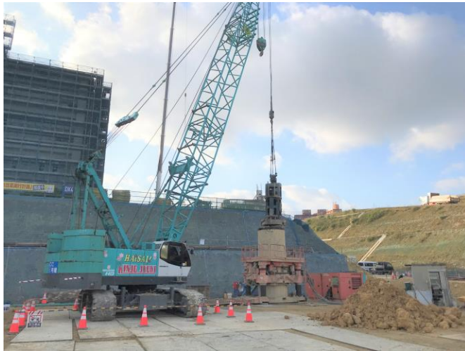
写真⑬(杭工事 D棟 掘削状況)
