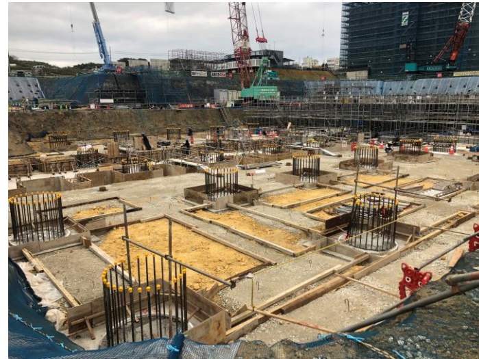
写真⑩(躯体工事 A棟 ベルコンリート打設前)
