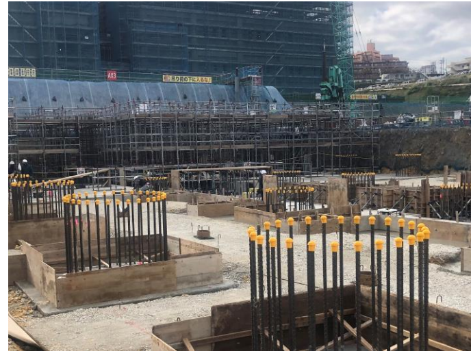
写真⑩(躯体工事 A棟 ベルコンクリート打設前)
