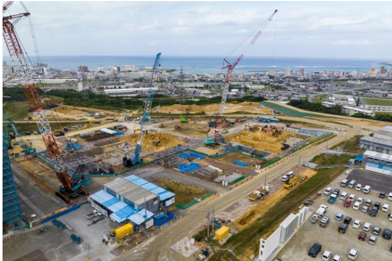
写真⑨(南東側)
