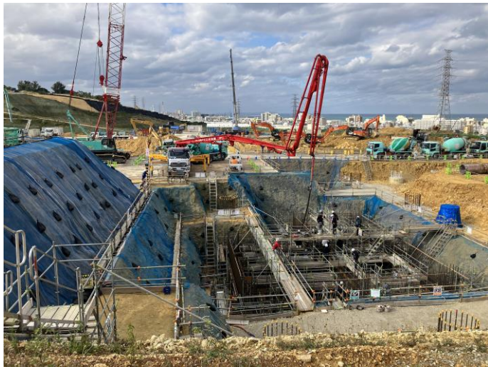
写真⑪ (躯体工事 B棟 基礎コンクリート打設状況)
