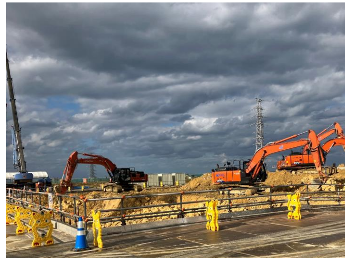
写真⑫ (土工事 C棟 掘削状況)
