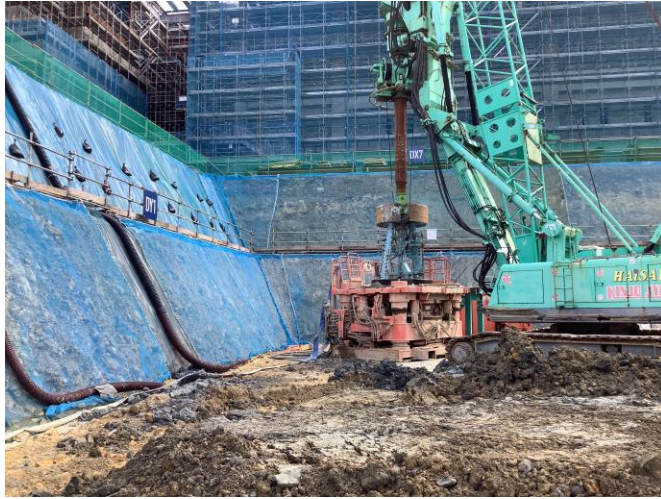
写真⑬(杭工事 D棟 拡底部掘削状況)
