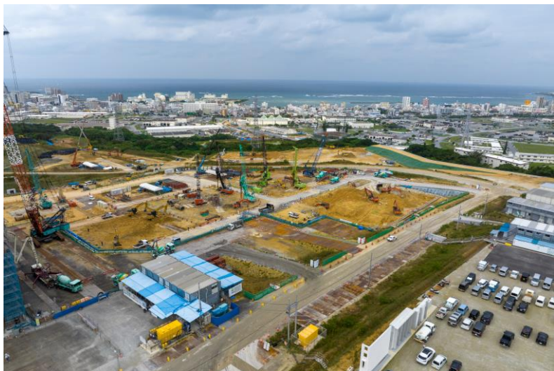
写真⑨(南東側)
