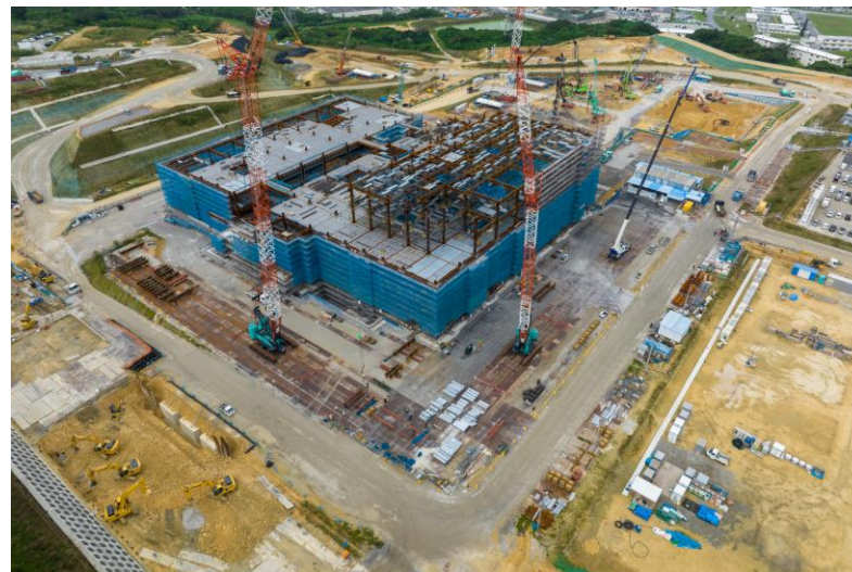
写真②(南南東側)
