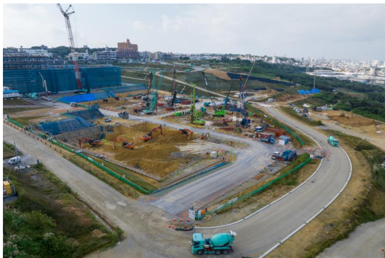
写真⑦(北北東側)
