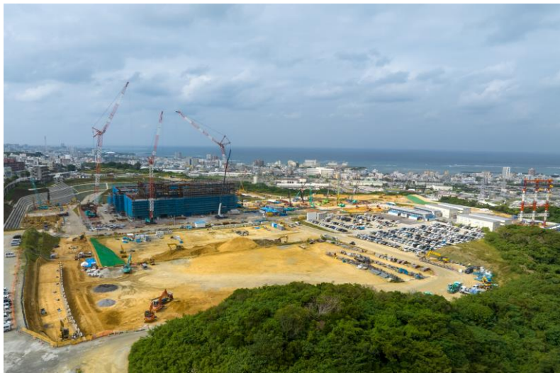
写真①(東南東側)
