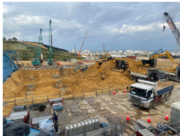
写真⑩(土工事 A棟 掘削状況)
