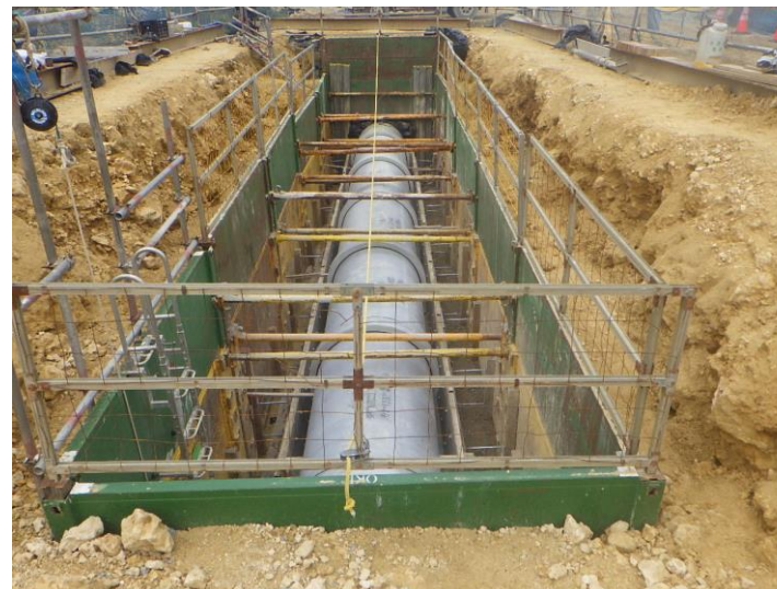
写真⑫(キャンパスアベニュー 雨水排水工事状況)
