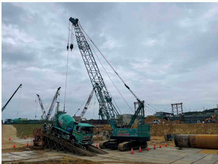
写真⑪(杭工事 D棟 コンクリート打設状況)
