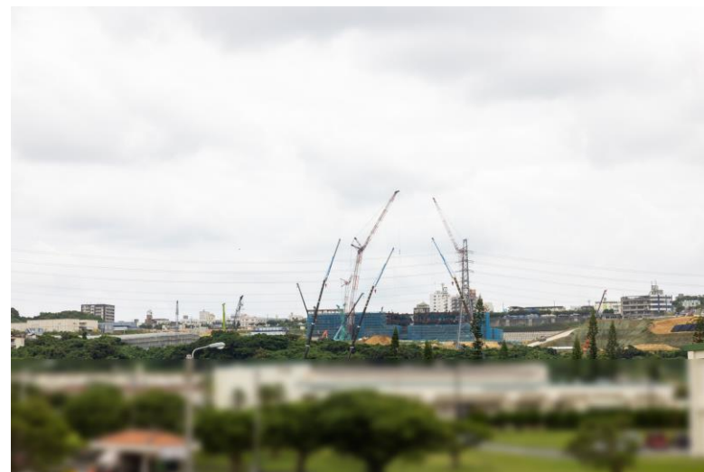
写真⑥(国道58号線高架橋より)
