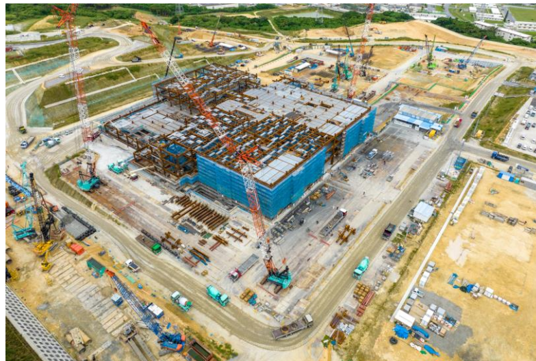
写真②(南南東側)
