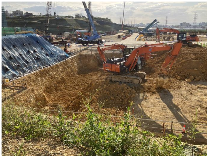
写真⑪(土工事 B棟 掘削状況)
