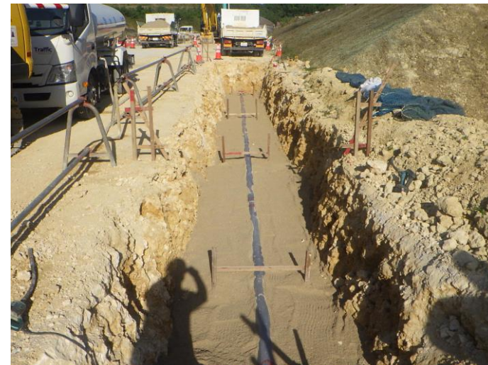
写真⑫(東側構内道路 汚水排水工事状況)
