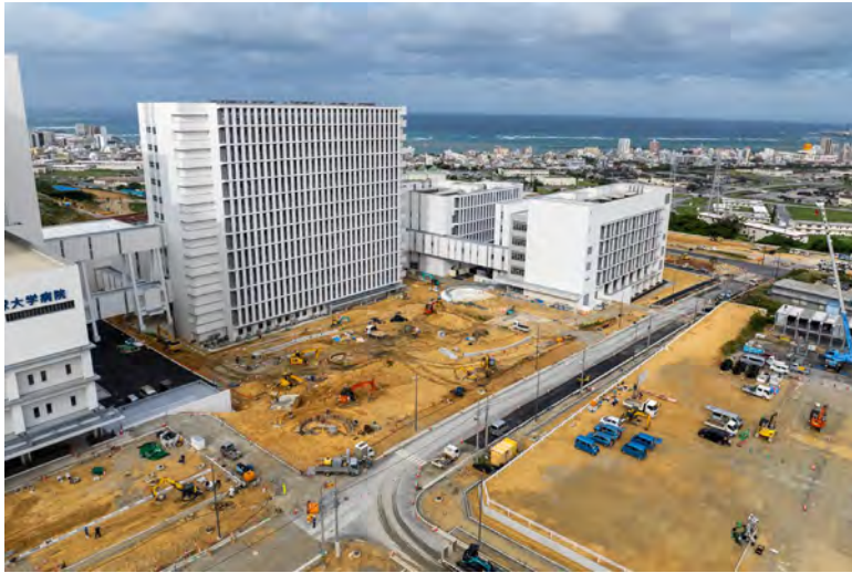
写真⑨(南東側)
