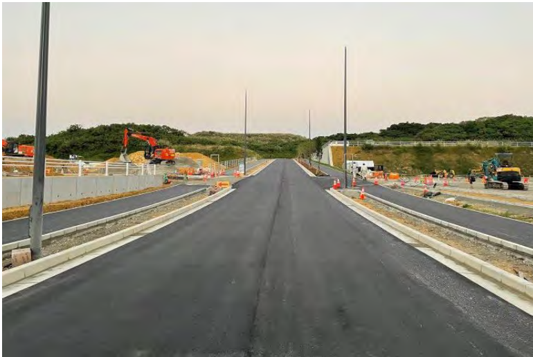
写真⑪ (構内道路 アスファルト舗装状況)
