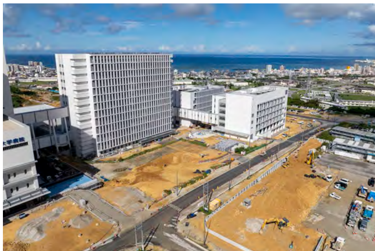
写真⑨(南東側)
