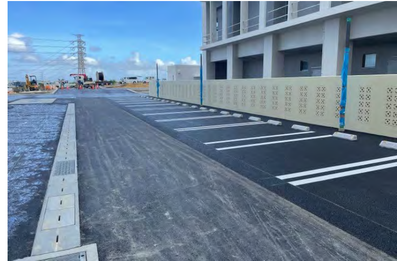
写真⑭ (B棟～C棟間 アスファルト舗装状況)
