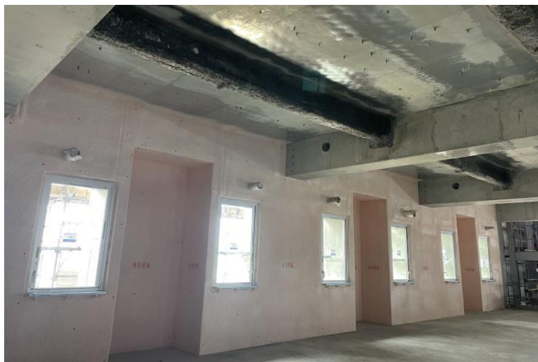
写真⑪ (A棟 断熱工事 10階 発泡ウレタン吹付状況)
