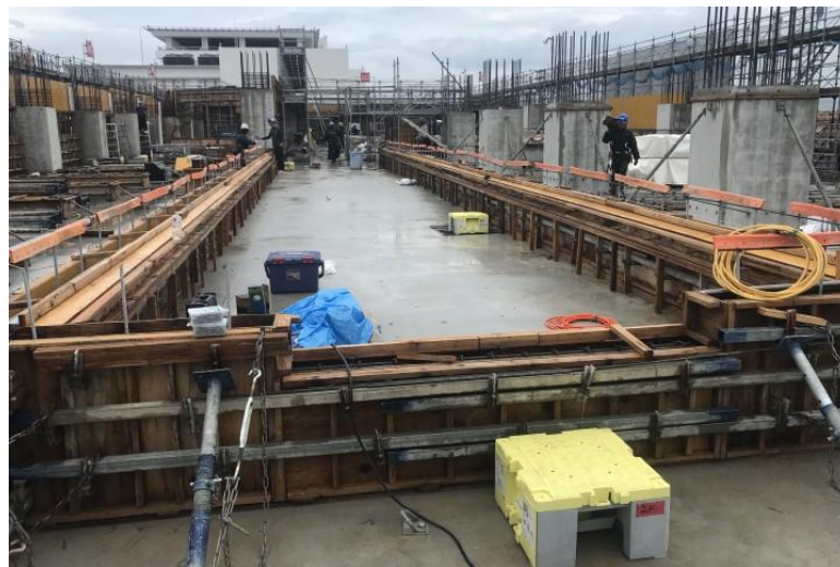
写真⑩ (A棟 型枠工事 13階 立上り建込状況)
