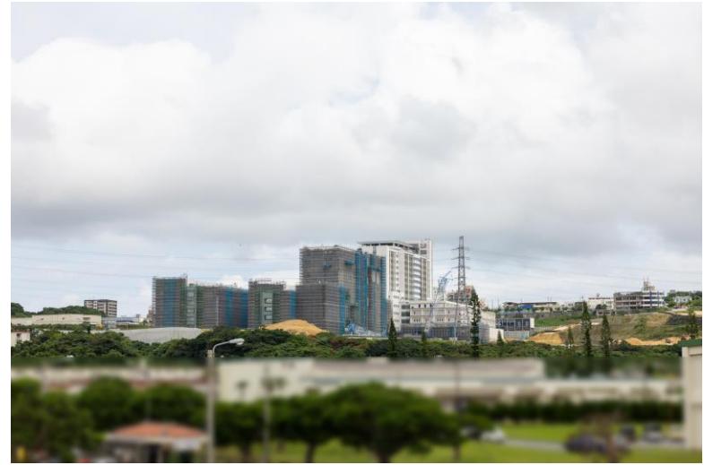
写真⑥(国道58号線高架橋より)
