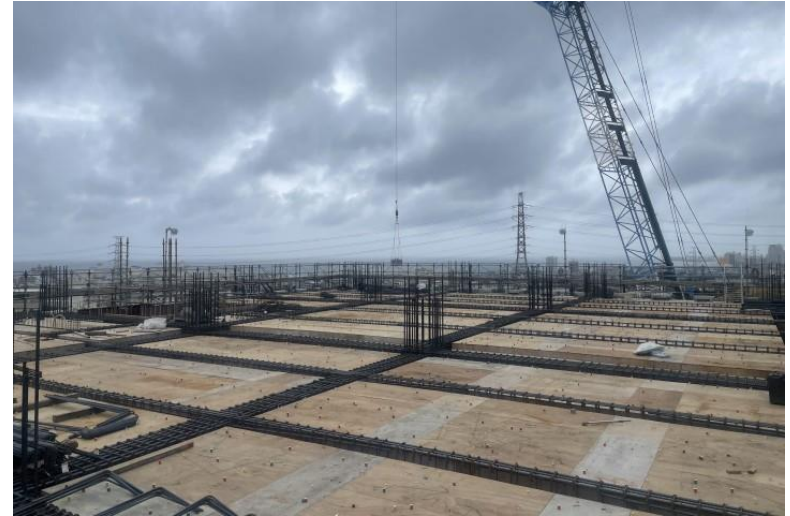
写真⑭ (D棟 型枠工事 4階 床施工状況)
