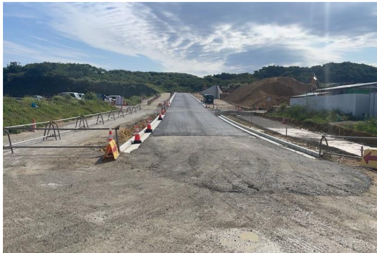
写真⑮ (構内道路 アスファルト舗装基層状況)
