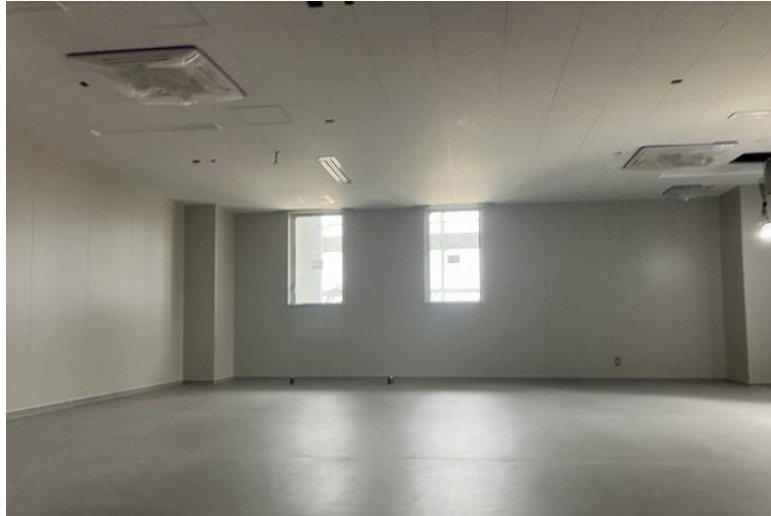
写真⑬ (C棟 内装工事 3階 内装仕上状況)
