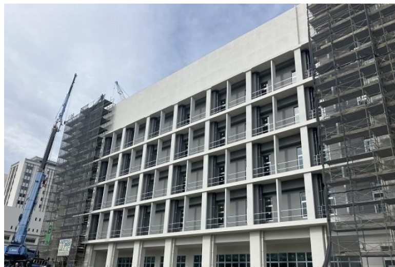
写真⑫ (B棟 仮設工事 東面足場解体状況)
