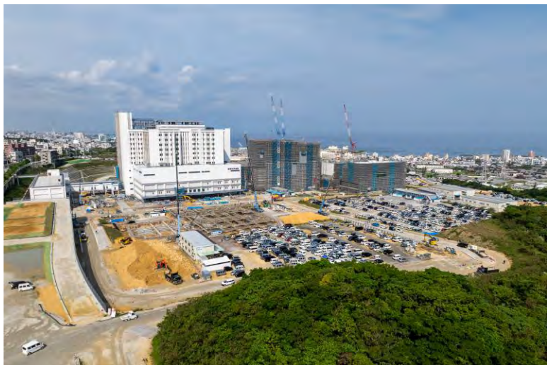
写真①(東南東側)
