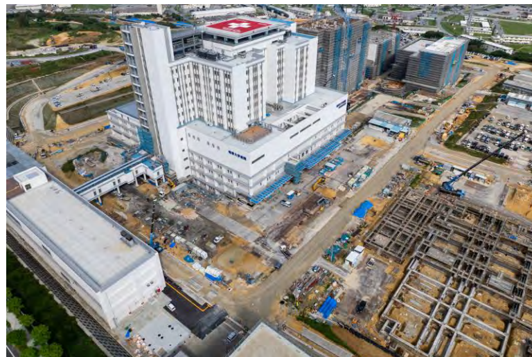
写真②(南南東側)
