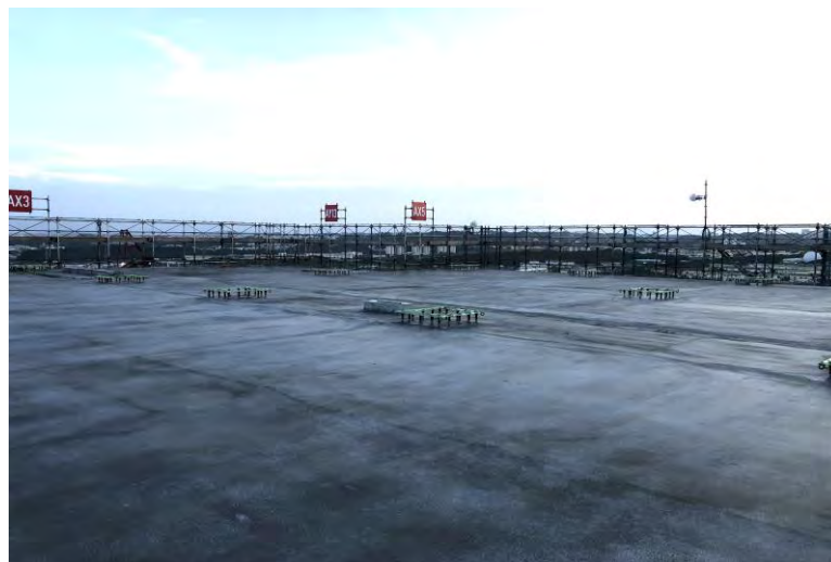
写真⑩(A棟 コンクリート工事 12階床コンクリート打設状況)
