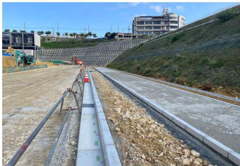
写真⑮(キャンパスニュー 歩車道ブロック設置状況)
