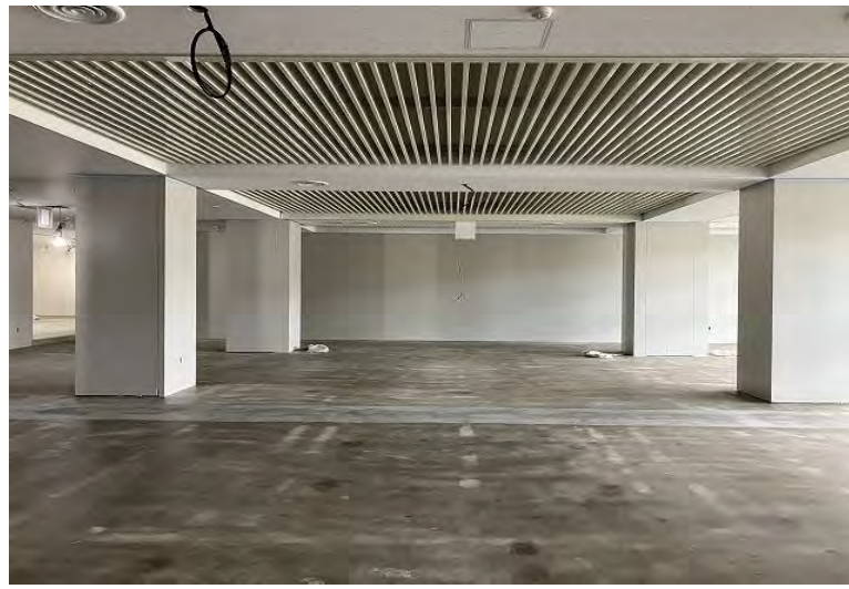
写真⑫ (B棟 内装工事 2階図書閲覧室仕上状況)
