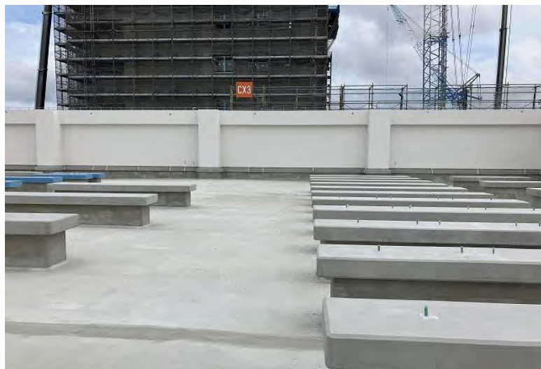
写真⑬(C棟 内装工事 屋上防水下地施工状況)
