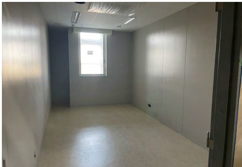
写真⑪ (A棟 塗装工事 3階教授室仕上状況)
