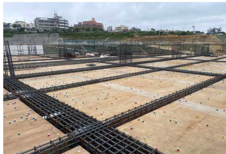
写真⑭(D棟 型枠工事 3階スラブ 施工状況)
