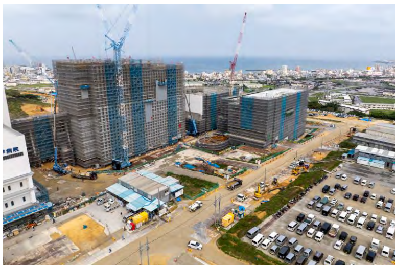
写真⑨(南東側)
