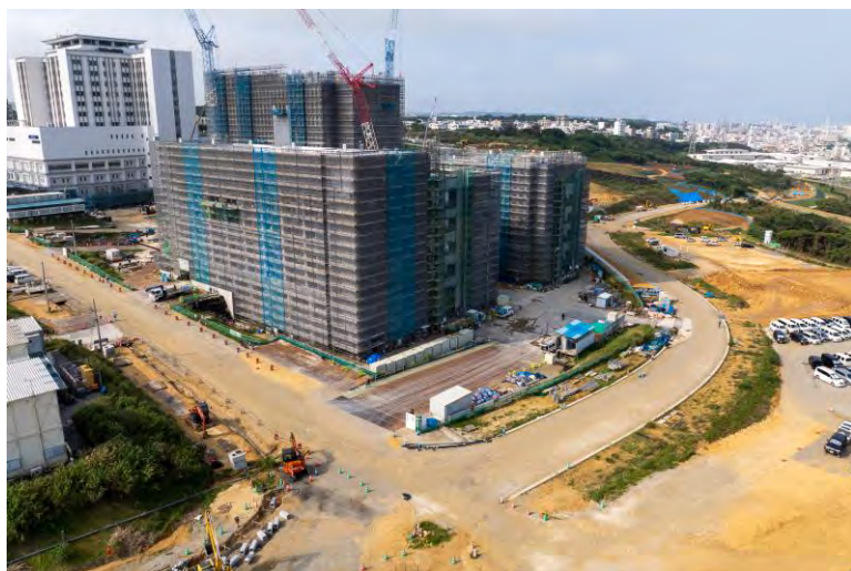
写真⑦(北北東側)
