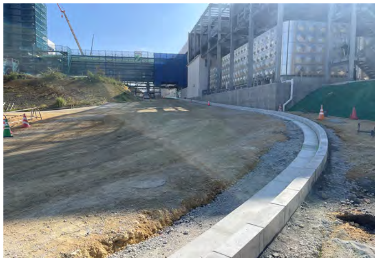
写真⑮(キャンパスペース ニュー 歩車道ブロック設置状況)
