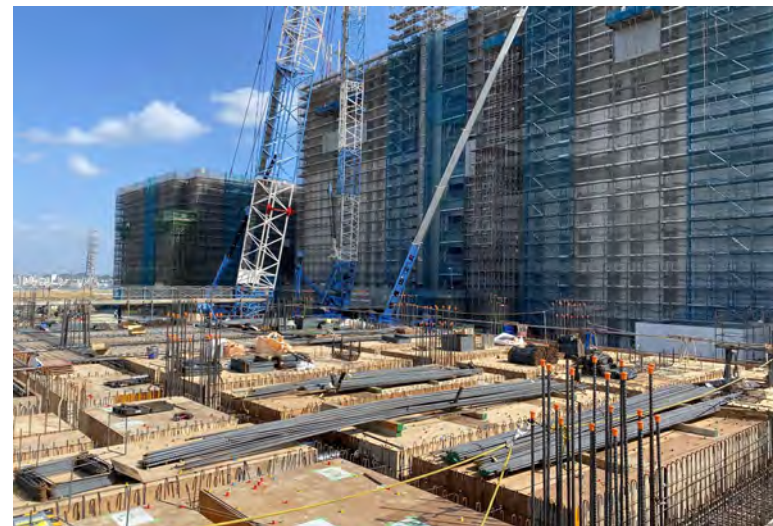
写真⑭(D棟 鉄筋工事 2階梁配筋状況)
