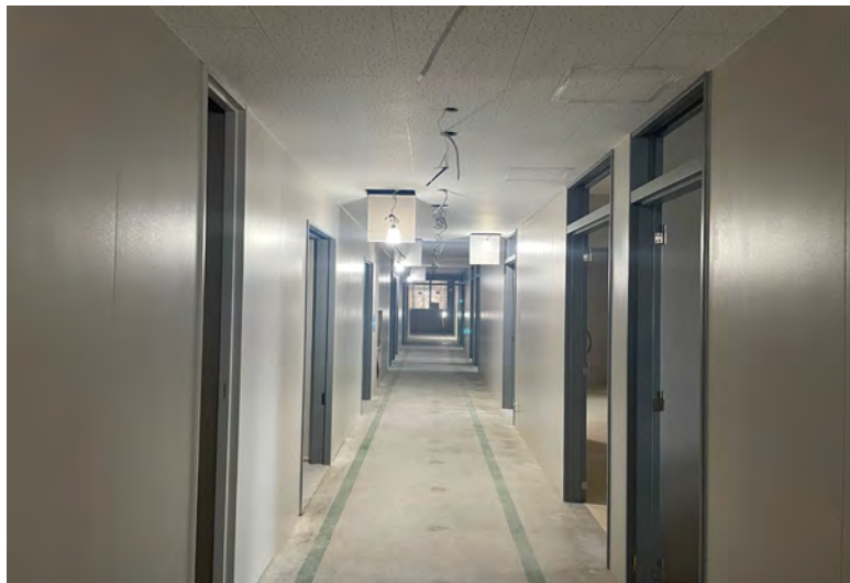
写真⑪ (A棟 塗装工事 2階廊下壁塗装状況)
