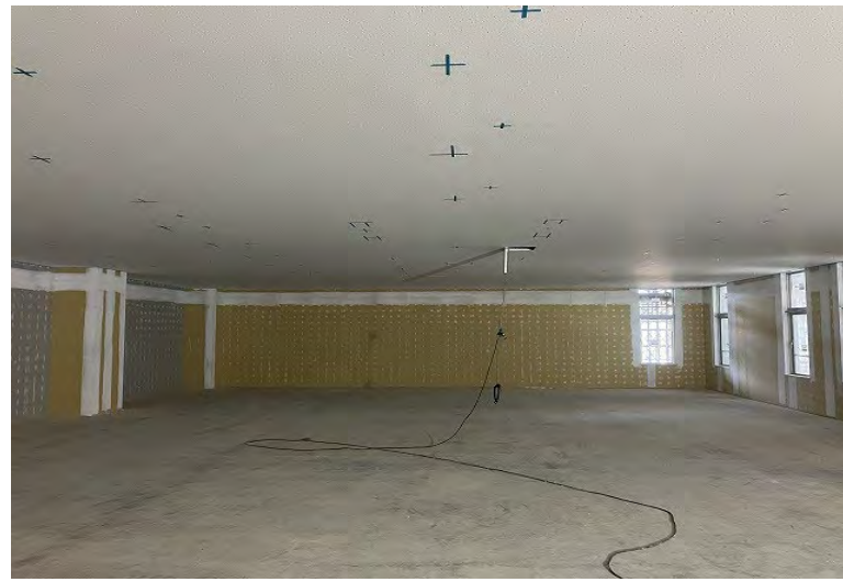
写真⑫ (B棟 内装工事 2階天井ボード施工状況)
