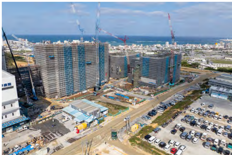
写真⑨(南東側)
