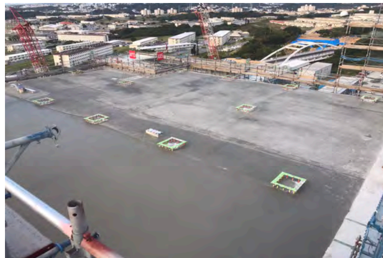
写真⑩(A棟 コンクリート工事 11階床コンクリート打設状況)
