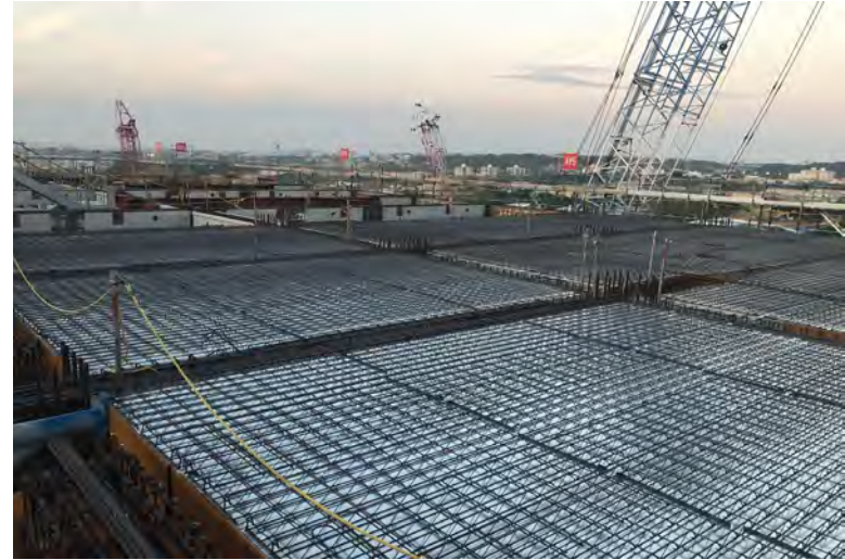
写真⑩(A棟 鉄骨工事 10階鋼製床施工状況)
