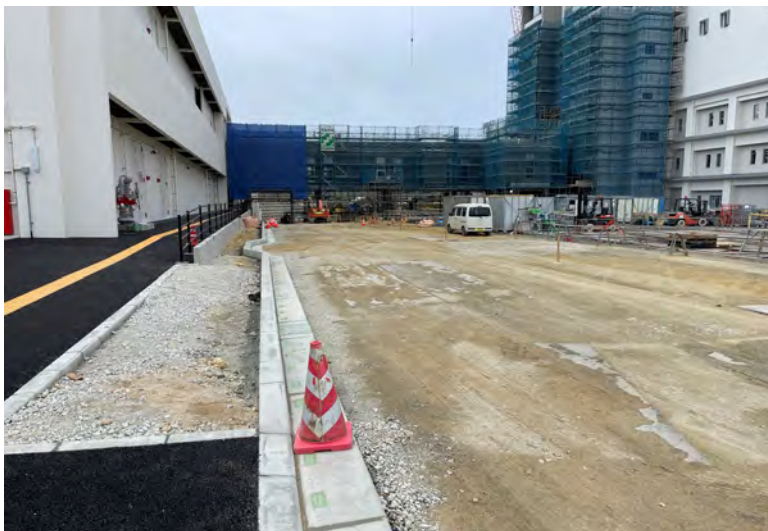
写真⑮(キャンパスアベニュー 歩車道ブロック設置状況)
