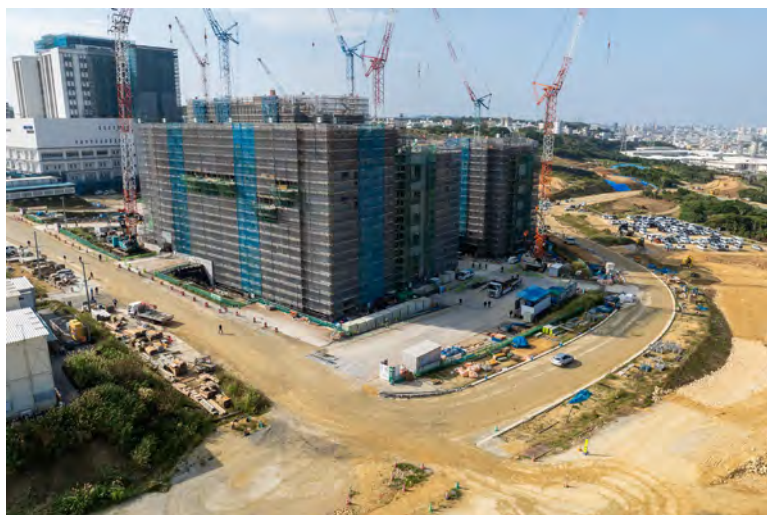
写真⑦(北北東側)
