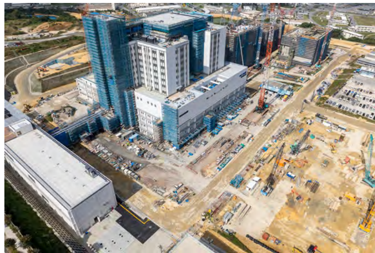
写真②(南南東側)
