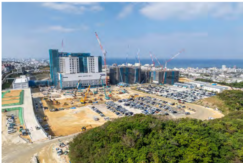
写真①(東南東側)
