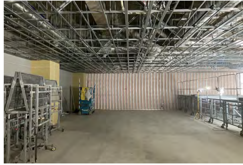
写真⑫ (B棟 金属工事 2階天井軽量鉄骨下地施工状況)
