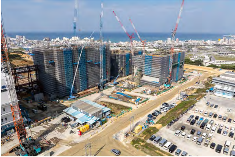
写真⑨(南東側)
