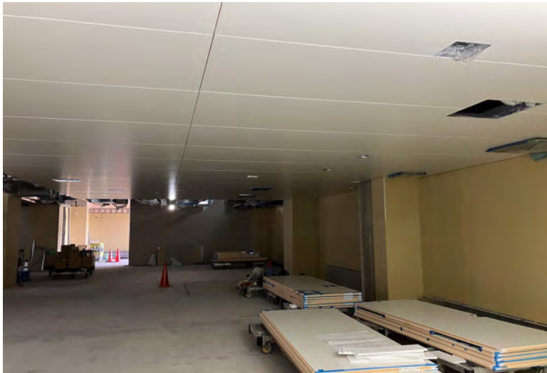
写真⑬(C棟 内装工事 2階歩行天井施工状況)
