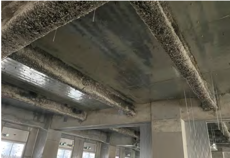
写真⑪ (A棟 鉄骨工事 6階耐火被覆吹付状況)
