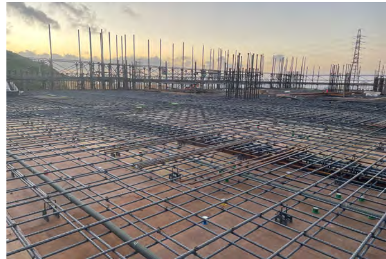
写真⑭(D棟 鉄筋工事 1階床配筋状況)
