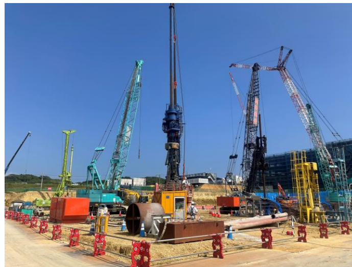
写真⑩(杭工事 A棟杭の拡底部掘削状況)
