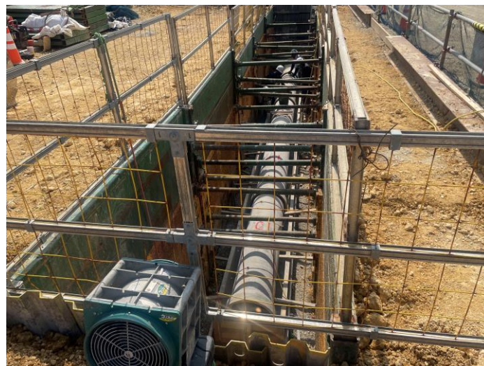
写真⑫(東側構内道路 雨水排水工事状況)
