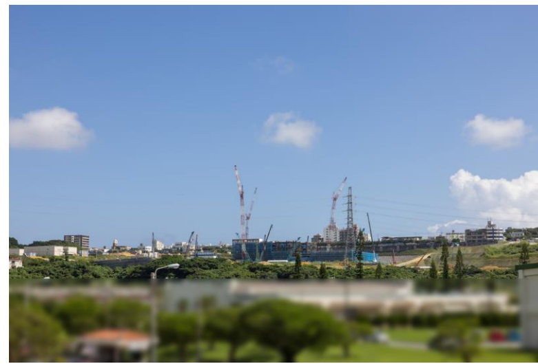
写真⑥(国道58号線高架橋より)
