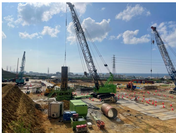
写真⑪(杭工事 B棟杭のケーシング建込状況)
