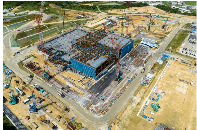
写真②(南南東側)
