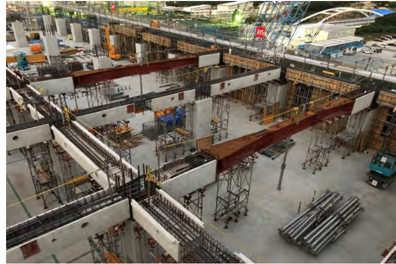
写真⑩(A棟 PCa工事 9階梁架設状況)
