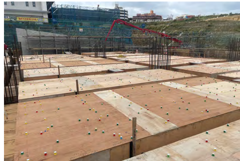
写真⑭(D棟 型枠工事 1階床施工状況)
