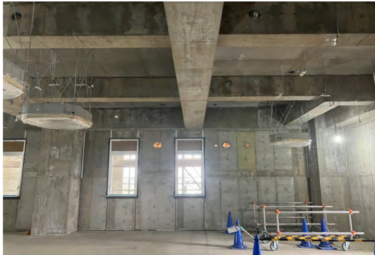
写真⑬(C棟 機械設備工事 3階天井内状況)
