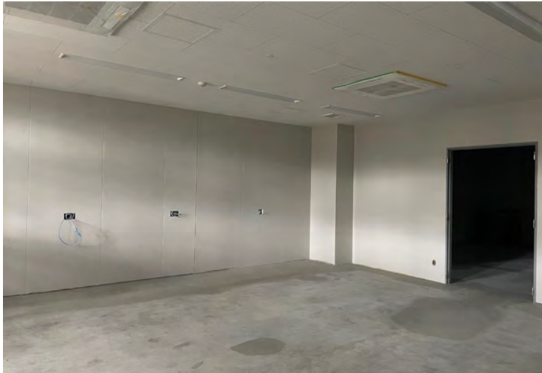
写真⑪ (A棟 塗装工事 2階壁塗装状況)
