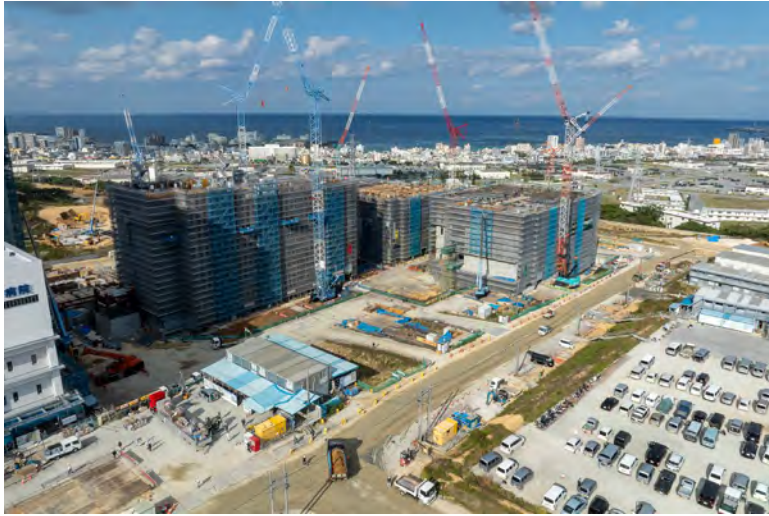
写真⑨(南東側)
