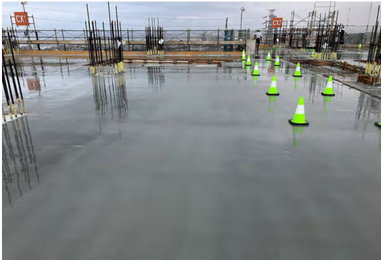
写真⑬(C棟 コンクリート工事 5階床コンクリート打設状況)
