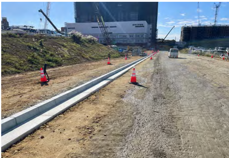
写真⑮(構内道路工事 歩車道ブロック設置状況)
