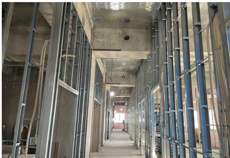
写真⑪ (A棟 金属工事 4階壁軽量鉄骨下地施工状況)
