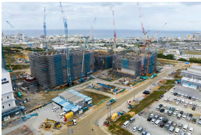
写真⑨(南東側)
