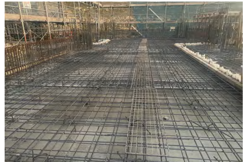
写真⑭(D棟 鉄筋工事 B1階床配筋状況)
