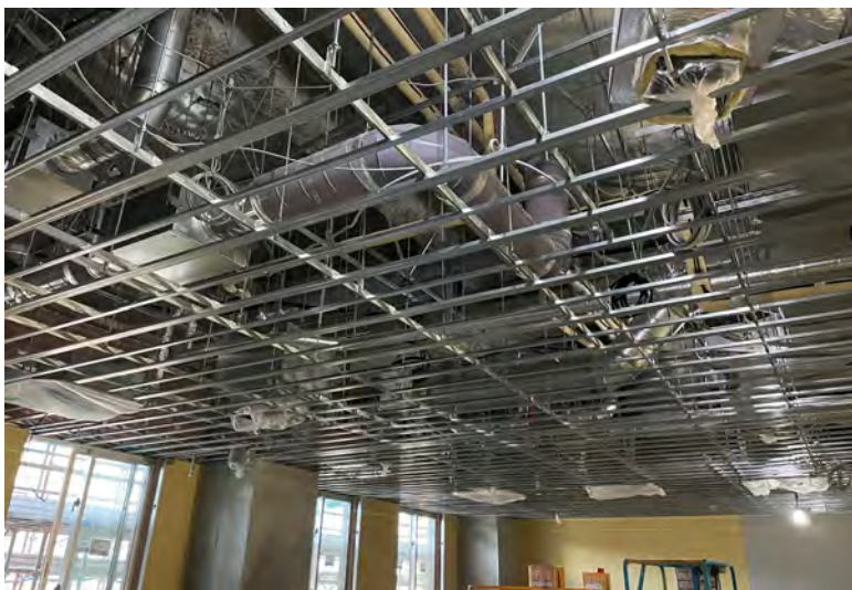
写真⑪ (A棟 金属工事 1階天井下地施工状況)
