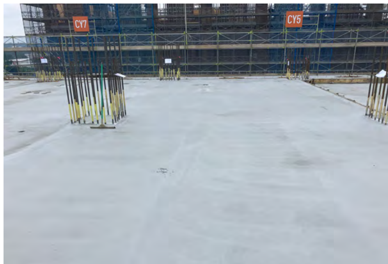
写真⑬(C棟 コンクリート工事 4階床コンクリート打設状況)
