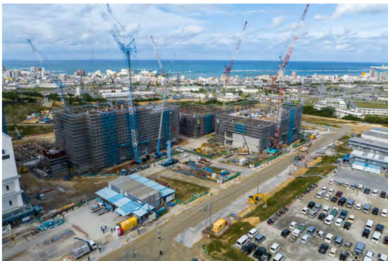
写真⑨(南東側)
