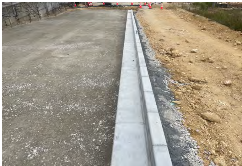
写真⑮(キャンパススペースニュー道路工事 歩車道ブロック設置状況)
