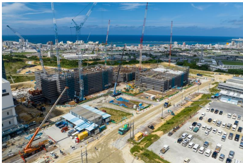
写真⑨(南東側)
