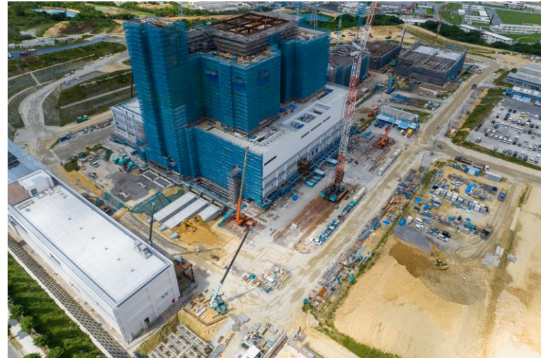
写真②(南南東側)
