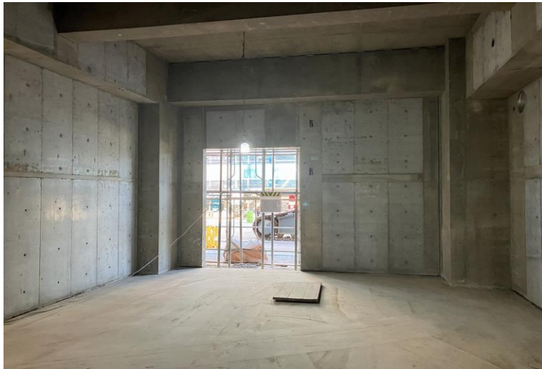
写真⑬(c棟 型枠工事 1階型枠解体状況)
