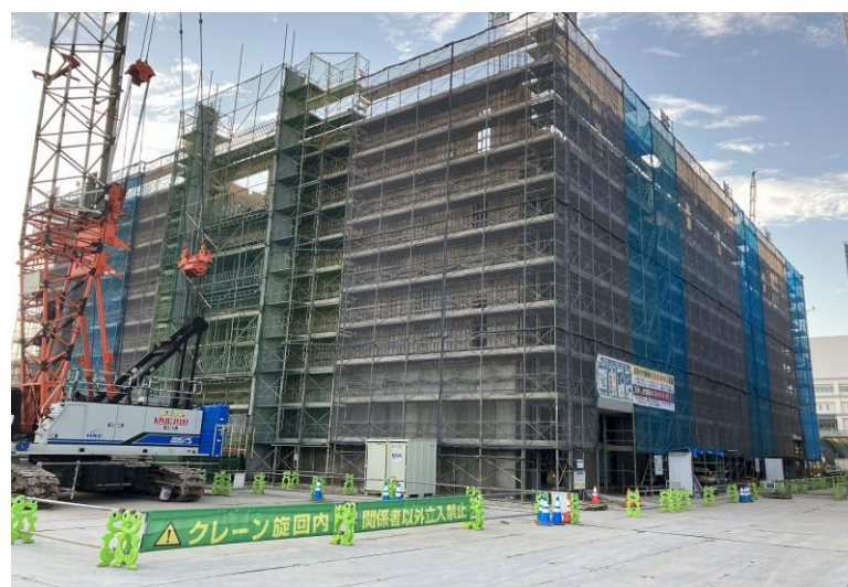
写真⑫ (B棟 仮設工事 5階足場組立状況)
