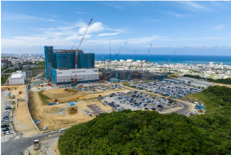
写真①(東南東側)
