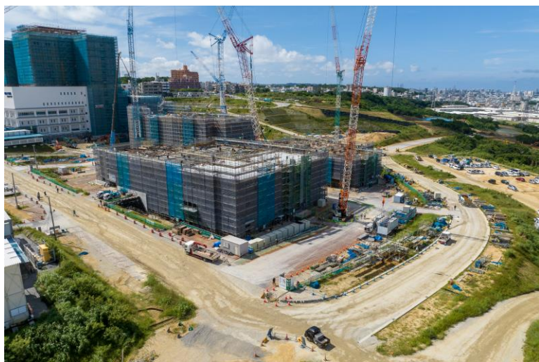
写真⑦(北北東側)
