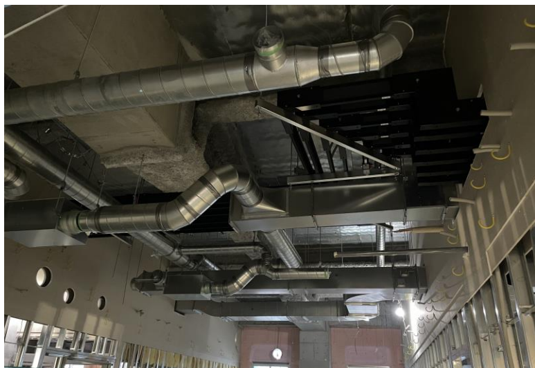
写真⑪ (A棟 空調工事 1階天井内ダクト施工状況)
