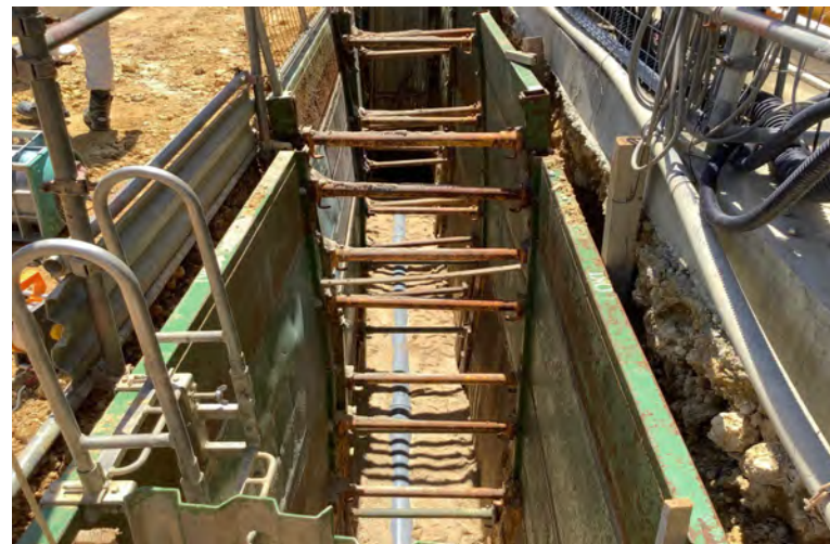
写真⑭(ホスト外アベニュー汚水配管工事 施工状況)
