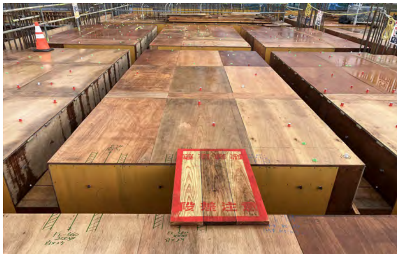
写真⑬(C棟型砕工事 3階ステップ型砕施工状況)
