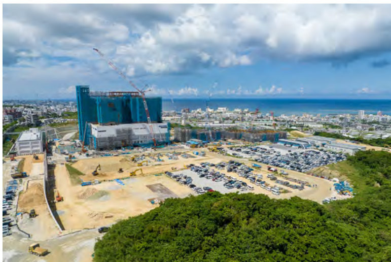
写真①(東南東側)
