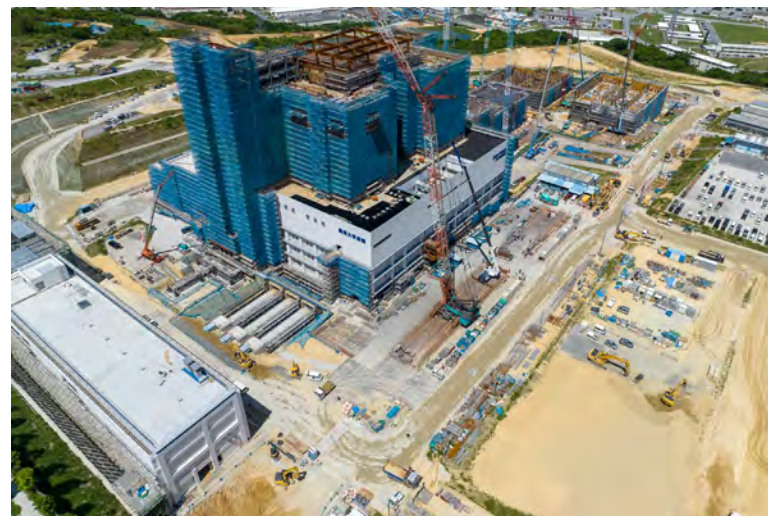
写真②(南南東側)
