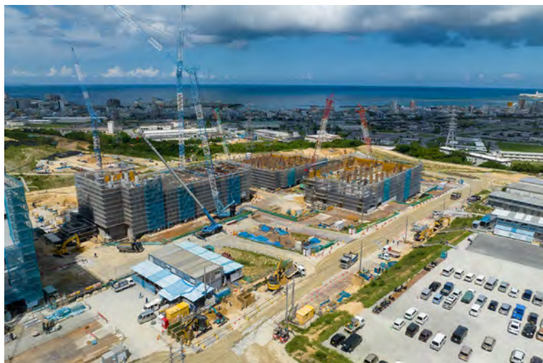
写真⑨(南東側)
