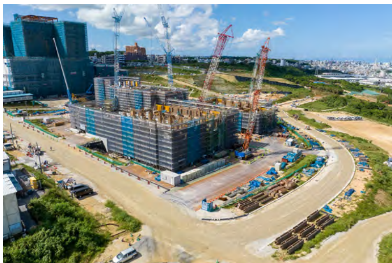
写真⑦(北北東側)
