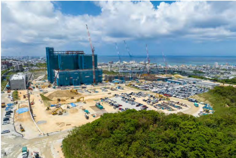
写真①(東南東側)
