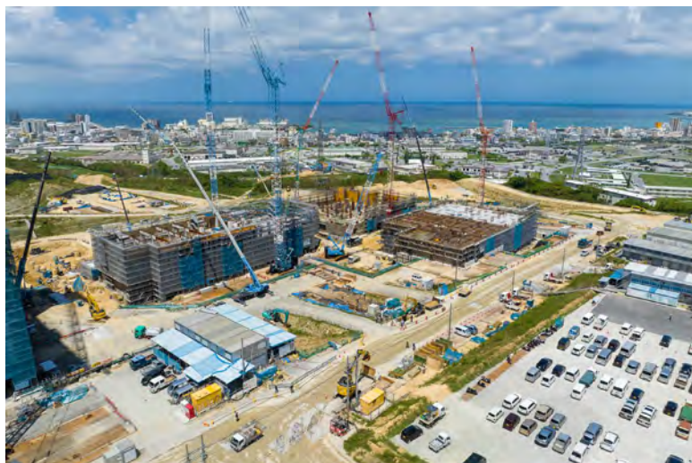
写真⑨(南東側)
