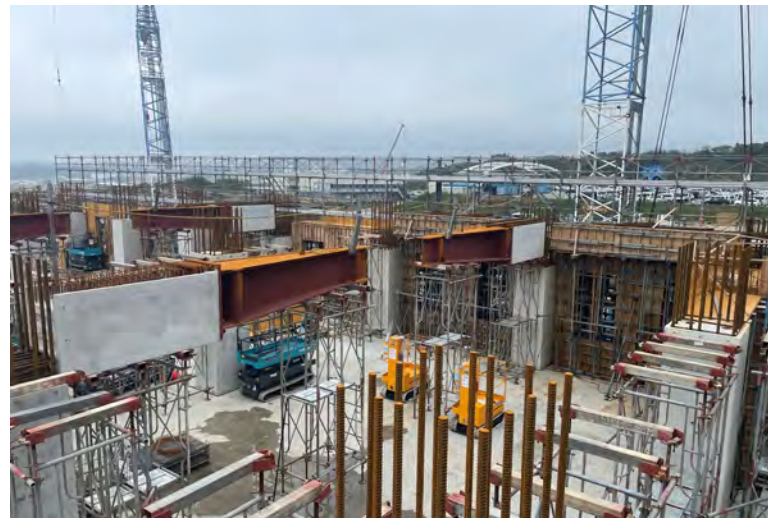
写真⑩(A棟 PCa工事 3階躯体取付状況)
