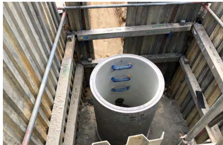
写真⑭(ホスピタルへニュー汚水配管工事 人孔設置状況)
