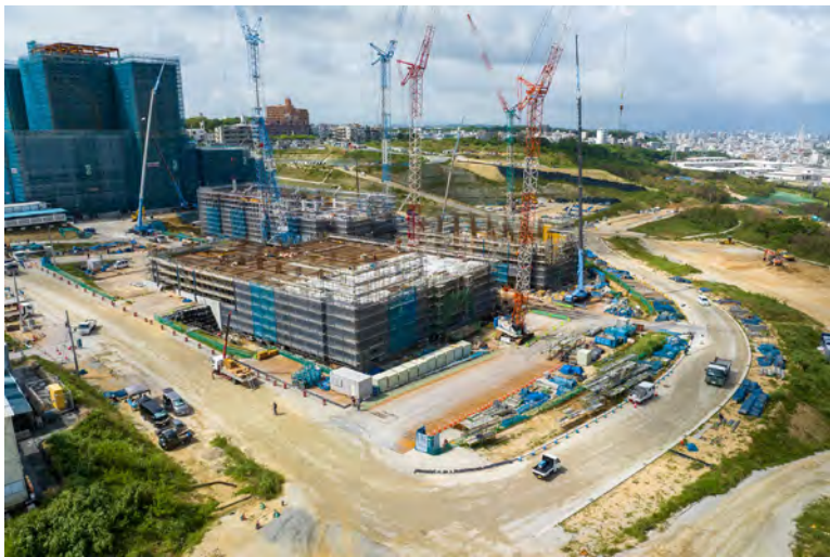
写真⑦(北北東側)
