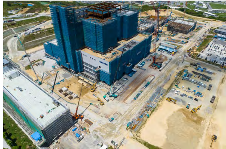
写真②(南南東側)
