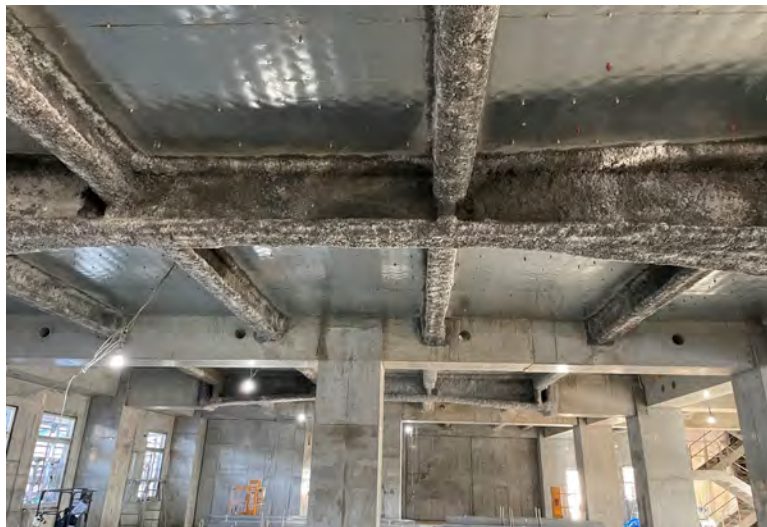
写真⑪ (A棟 耐火被覆工事 2階吹付状況)
