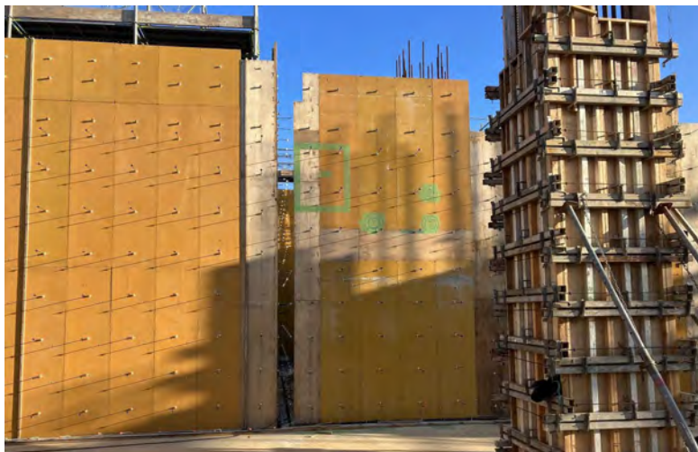
写真⑬(C棟 型枠工事 2階型枠施工状況)
