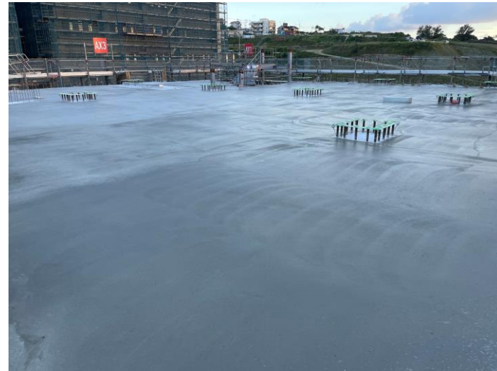
写真⑩(A棟コンクリート工事 3階床コンクリート打設状況)
