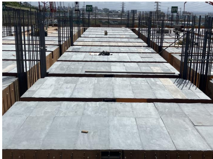
写真⑪ (B棟 型枠工事 3階スラブ 型枠施工状況)
