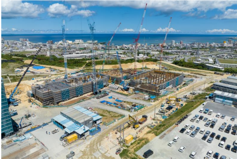
写真⑨(南東側)
