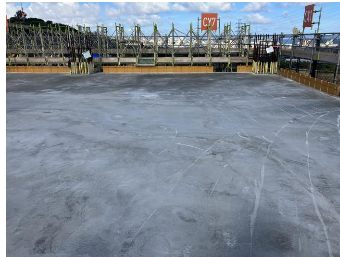
写真⑫ (C棟 コンクリート工事 2階床コンクリート打設状況)
