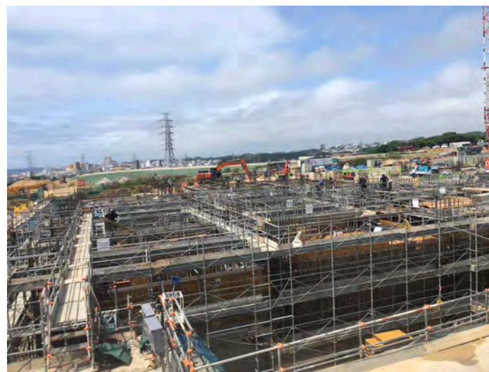
写真⑫(躯体工事 C棟 地中梁躯体工事状況)
