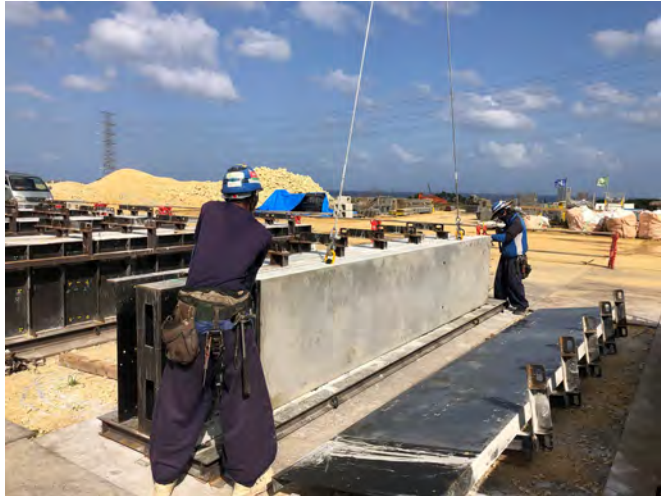
写真⑬(PCルバー工事状況)
