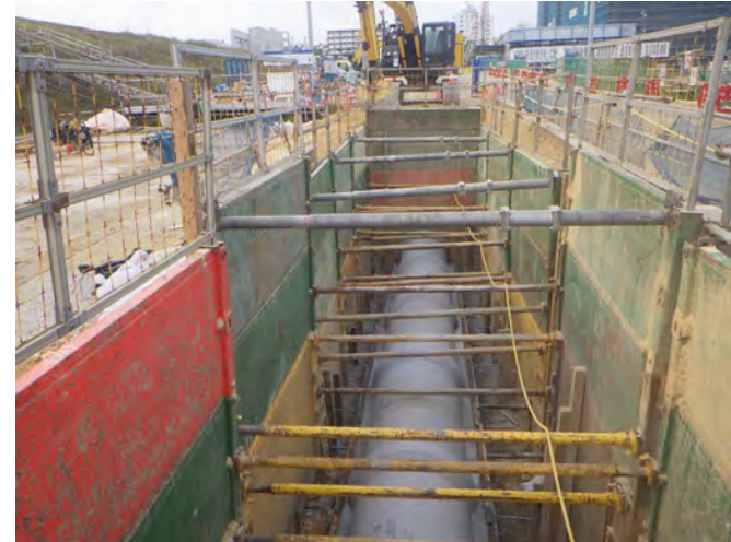
写真⑭(ホスピタルアベニュー 雨水排水工事状況)
