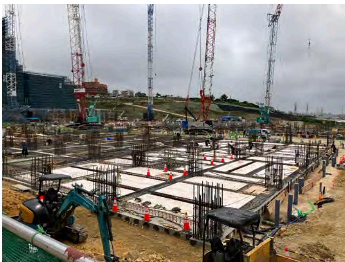
写真⑪(躯体工事 B棟 1階床躯体工事状況)
