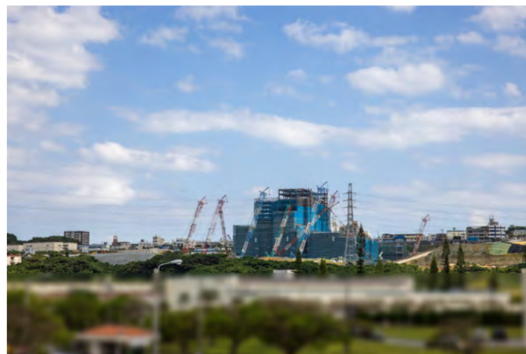
写真⑥(国道58号線高架橋より)
