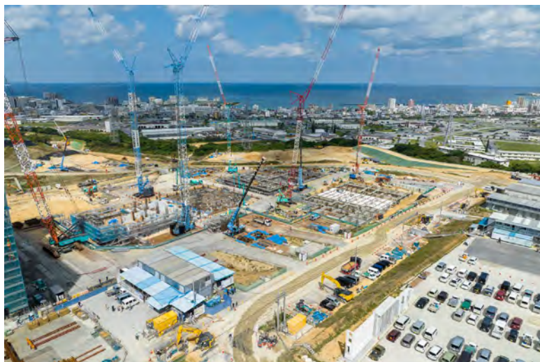
写真⑨(南東側)
