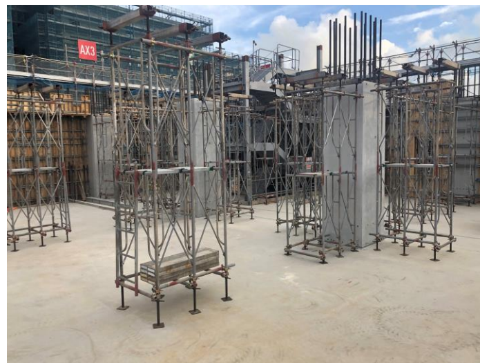
写真⑩(A棟 PCa工事 2階梁支保工組立状況)
