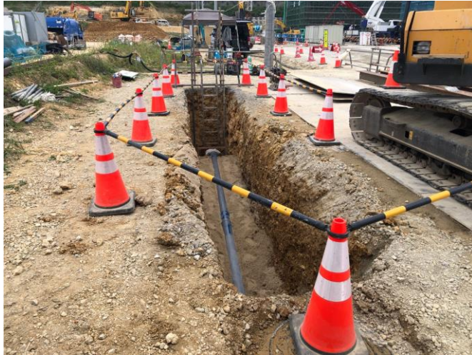
写真⑬(ホスピタルへニュー 汚水排水工事状況)
