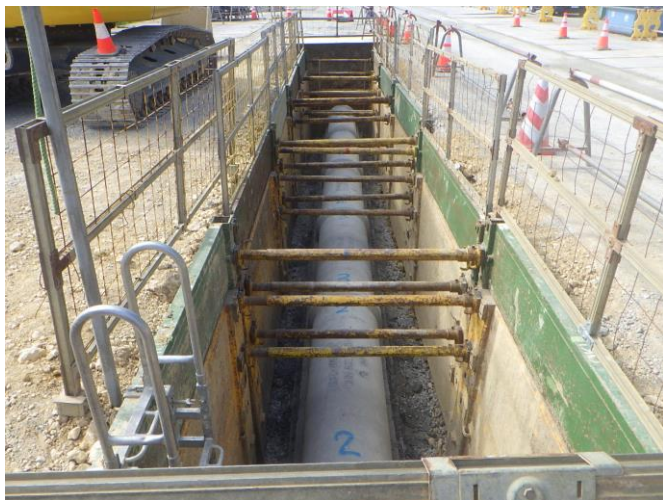
写真⑬(ホスピタルアベニュー 雨水排水工事状況)
