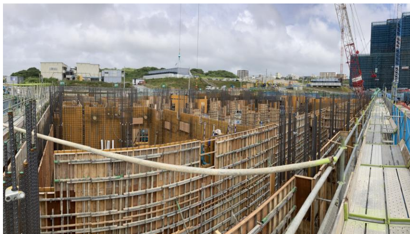
写真⑪ (躯体工事 B棟 1階躯体工事状況)
