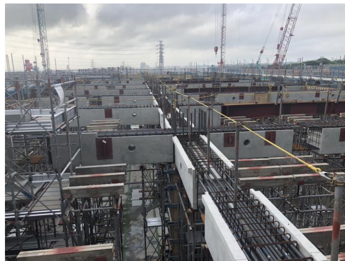
写真⑩(躯体工事 A棟 1階躯体工事状況)
