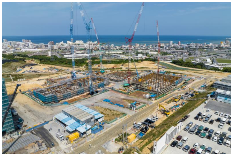
写真⑨(南東側)
