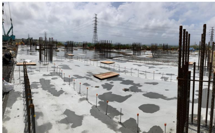
写真⑫ (躯体工事 C棟 1階床躯体工事状況)
