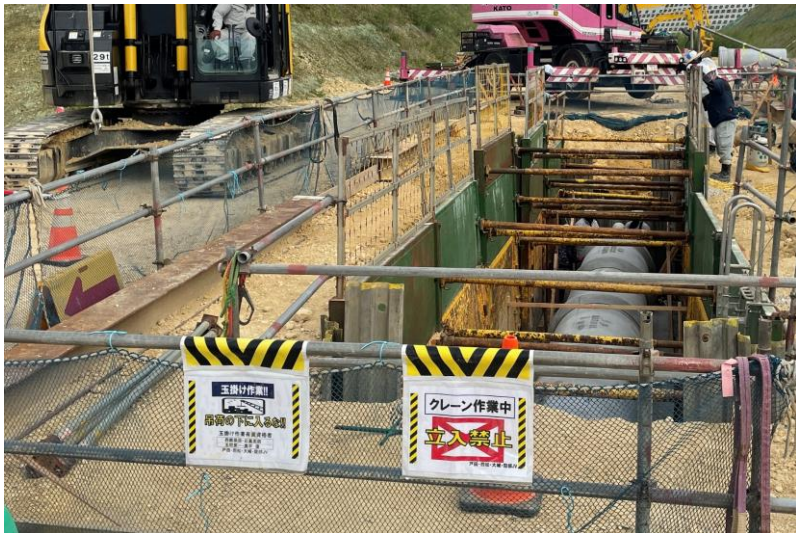
写真⑪(キャンパスアベニュー雨水排水工事状況)
