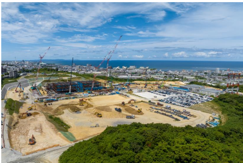
写真①(東南東側)
