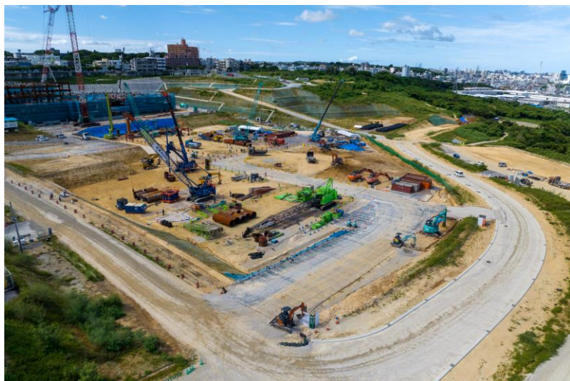
写真⑦(北北東側)
