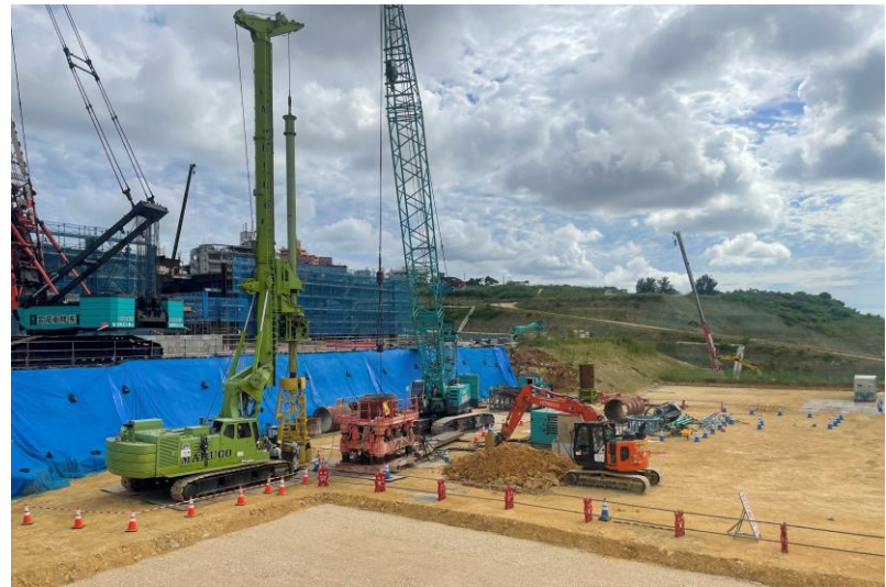
写真⑩(杭工事 A棟試験杭掘削状況)
