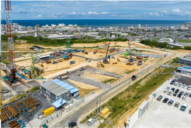
写真⑨(南東側)
