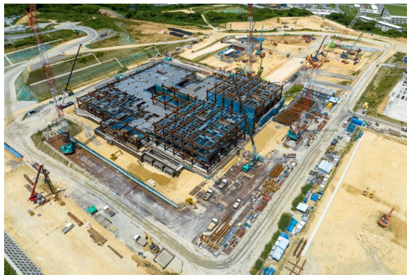
写真②(南南東側)
