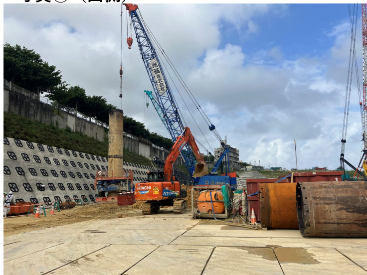
写真⑦（エネルギーセンター杭工事状況）
