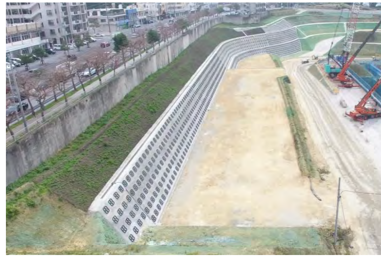
写真⑥（工事完成全景 北東上空より）
