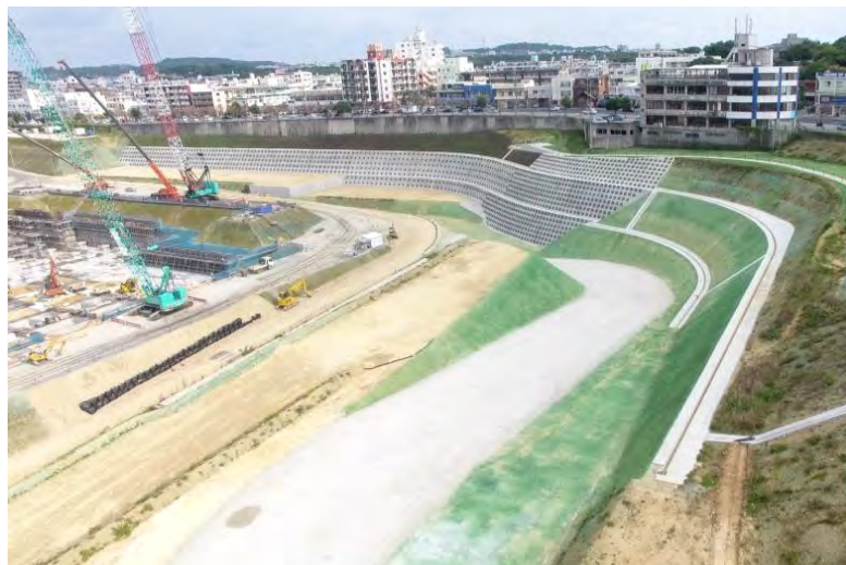
写真⑤（工事完成全景 南西上空より）
