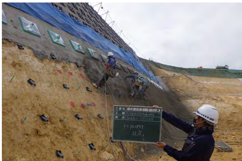
写真⑦（法面保護工 1段目 叩外吹付状況）
