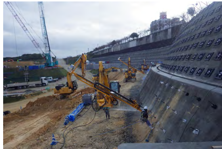
写真⑥（法面保護工 1段目 叩外 ノ ルト2台施工状況）
