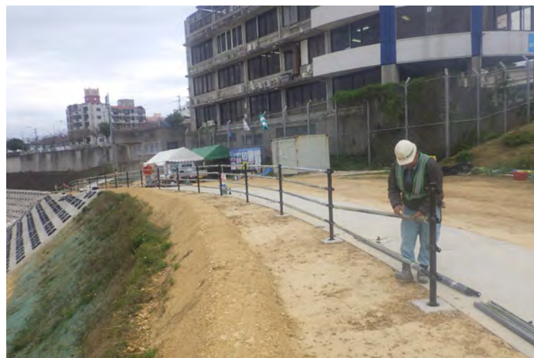
写真⑧（管理道 転落防止柵設置状況）
