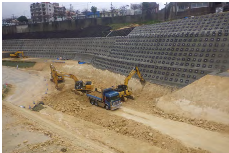
写真⑤（土工 残土搬出及び1段目 法面整形）
