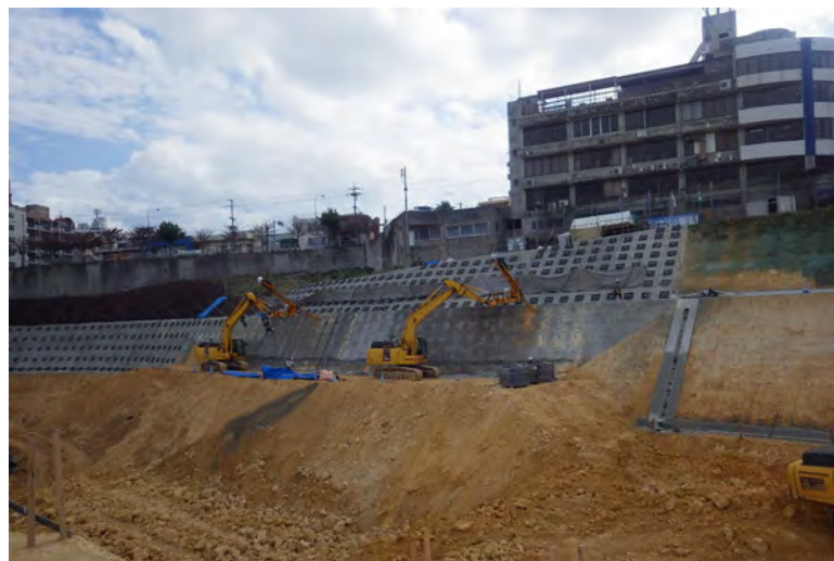
写真⑤ (法面保護工 ロッド削孔2台施工)
