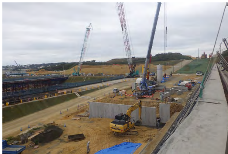
写真⑦ (プレキャストL型2号擁壁設置)
