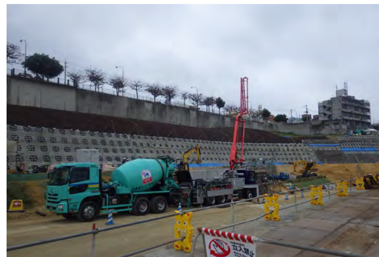
写真⑧ (現場打ちL型2号擁壁コンクリート打設状況)
