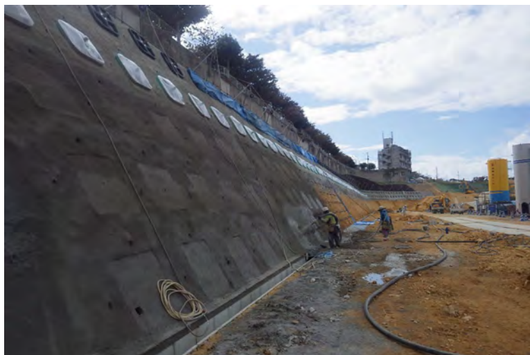
写真⑦ (法面保護工2段目2回目 丸外吹付状況)
