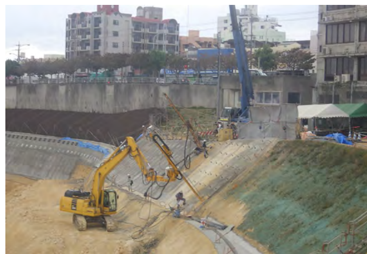
写真⑥ (法面保護工 ロックリ削孔2台施工)
