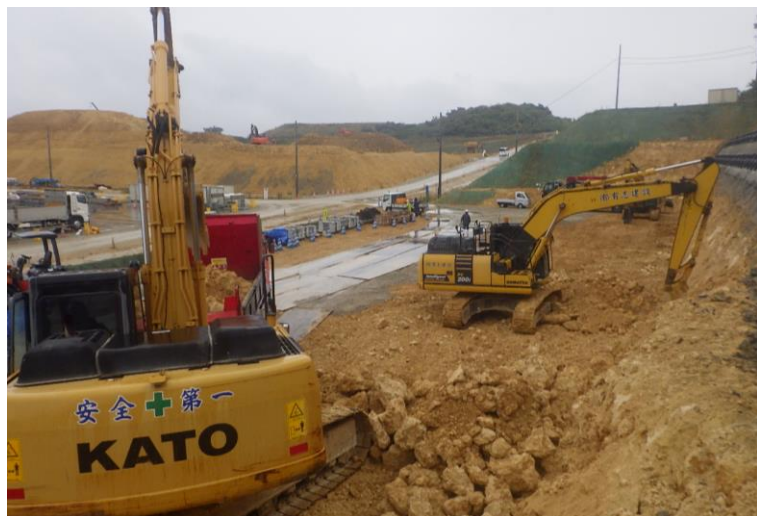
写真⑤ (土工 掘削積込み状況)
