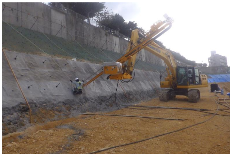
写真⑦ (法面保護工2段目 ロックボルト削孔状況)
