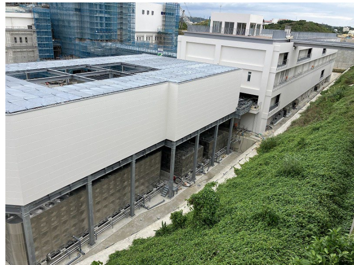
写真④（南西側 設備建屋）
