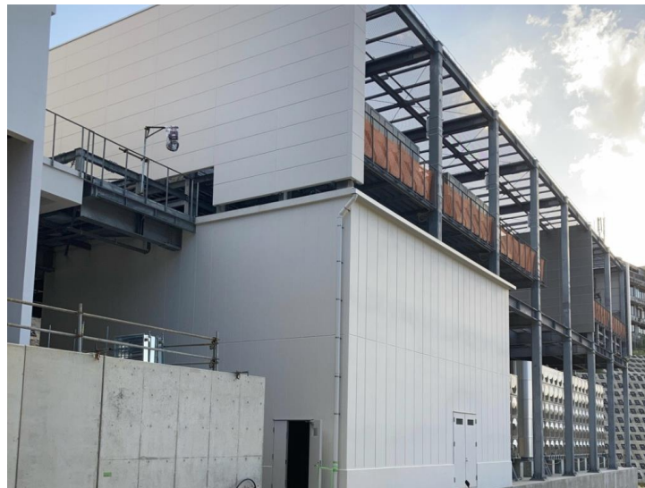
写真①（北東側 設備建屋）
