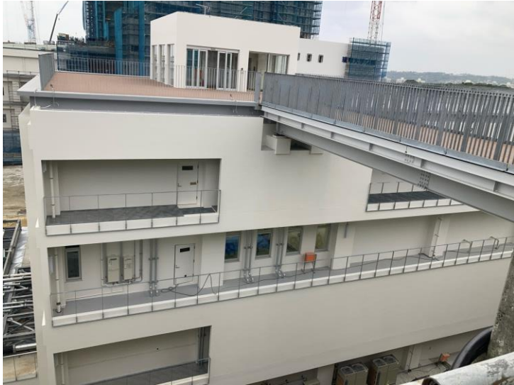
写真⑤ (南側 エネルギーセンター)
