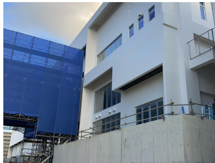
写真②（北東側 エネルギーセンター）
