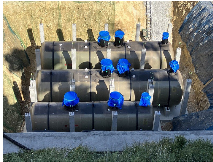
写真⑧ (外構 オイルタンク据付工事)
