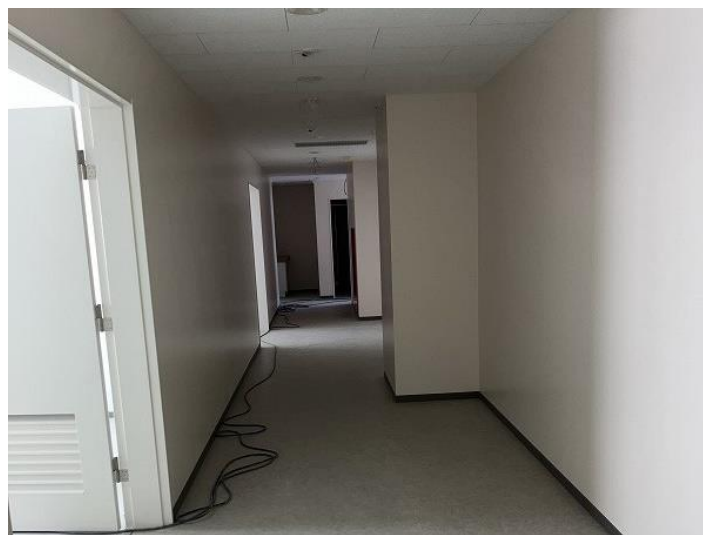
写真⑧（3階廊下 内装工事施工状況）
