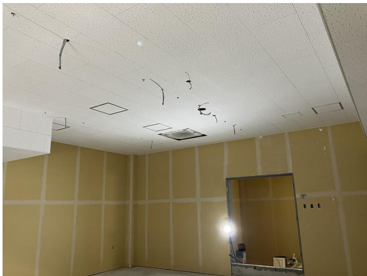
写真⑦（エネルギーセンター中央監視室内装工事）
