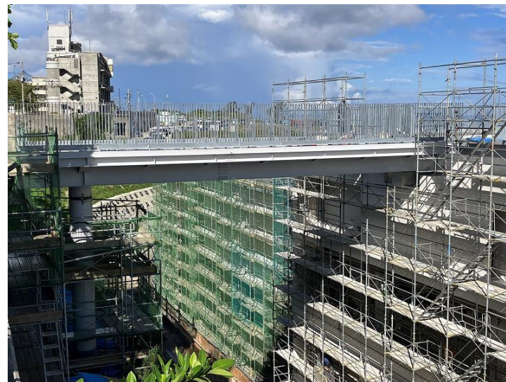
写真⑧（歩行デッキ設置工事）
