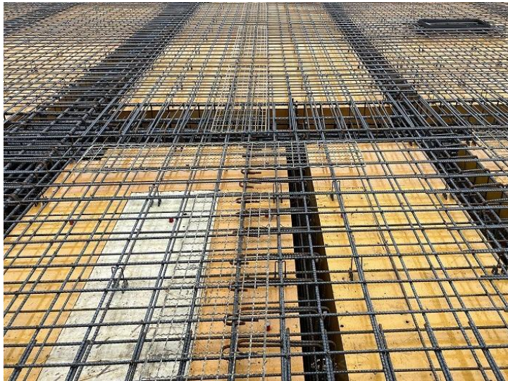
写真⑦ (エネルギーセンター屋上)
