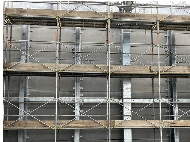
写真⑧ (設備建屋外壁)
