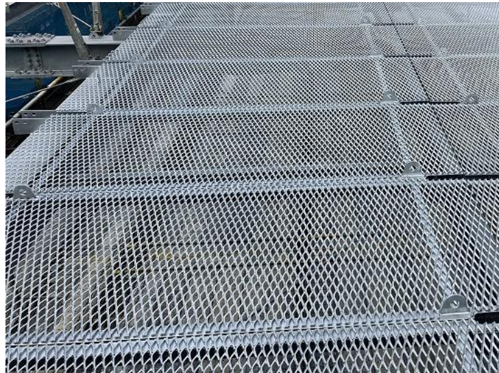
写真⑧（設備建屋屋根）
