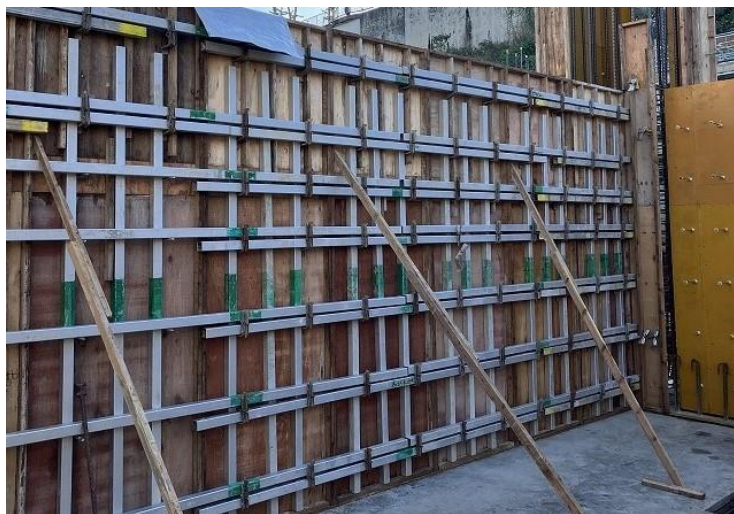
写真⑦（エネルギーセンター1階躯体）
