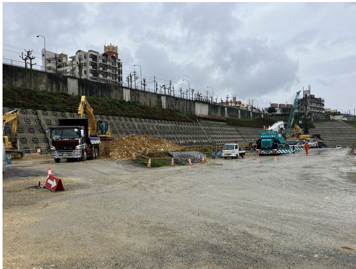
写真③ (北東側)
