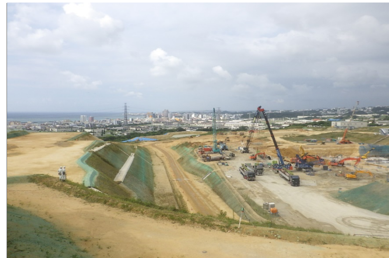
写真④（北東側）
