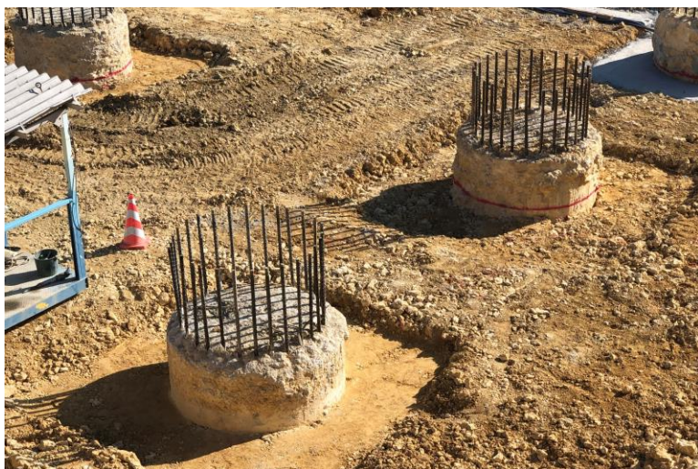
写真⑪(土工事 掘削完了状況)
