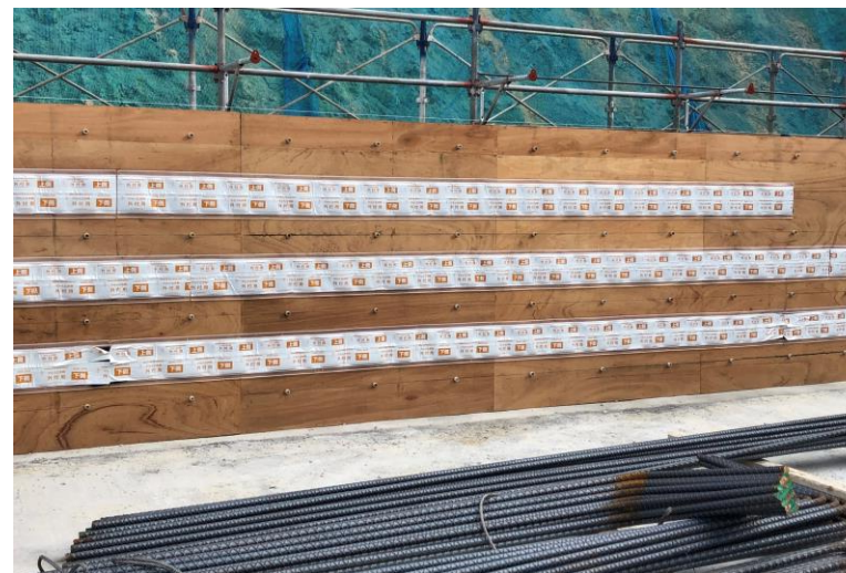
写真⑫(防水工事 止水板取付状況)
