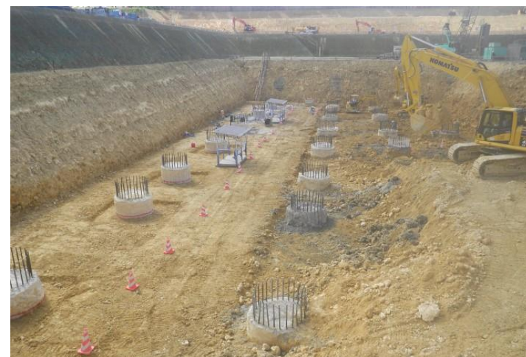
写真⑫(土工事 一部掘削完了状況)
