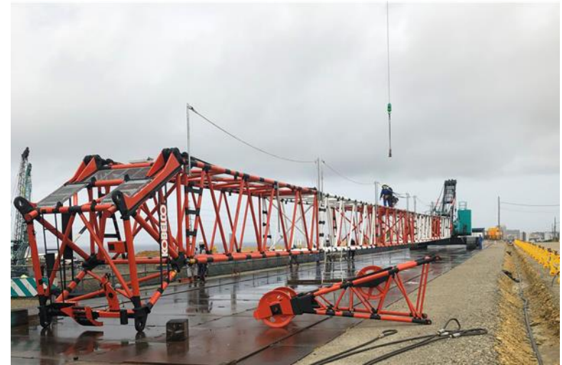
写真⑭(クローラークレーン組立状況)
