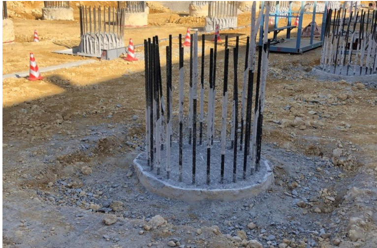
写真⑬(杭頭斫り状況)
