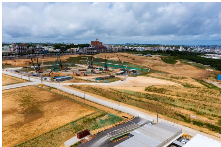
写真⑨(北東側)
