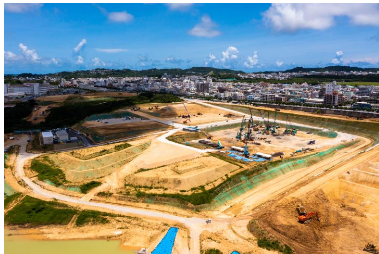
写真⑦(北西側)
