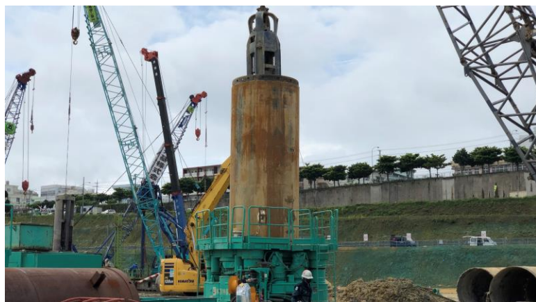
写真⑪(杭工事状況)
