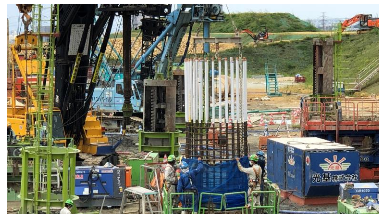
写真⑫(杭工事状況)
