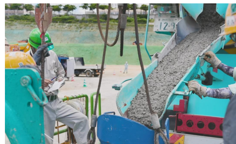
写真⑫(杭工事 コンクリート打設状況)
