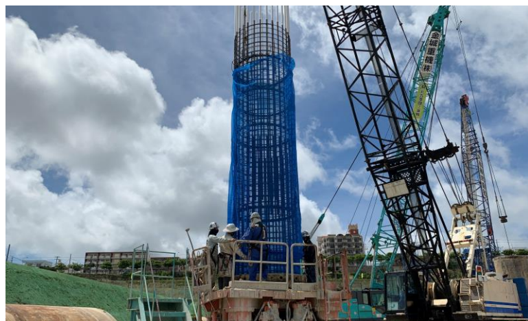
写真⑪(杭工事 鉄筋籠建込み状況)
