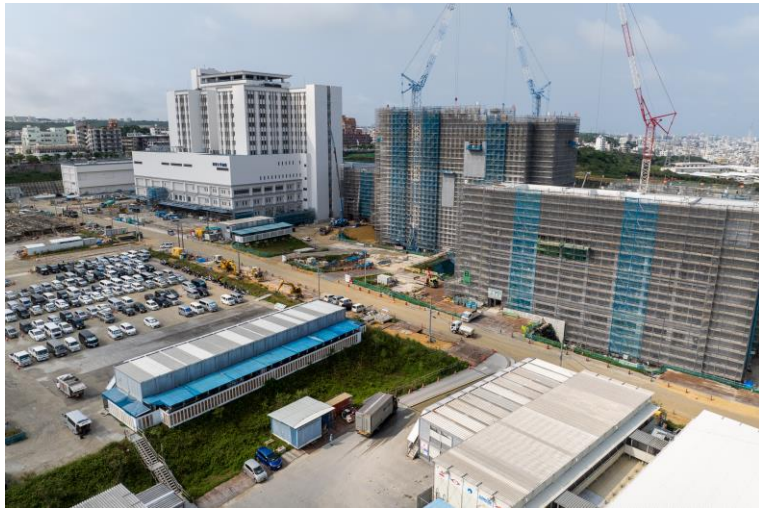
写真⑨(北東側)
