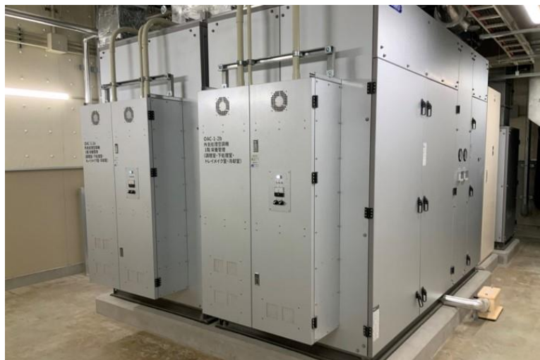
写真⑬(機械工事 機械室施工状況)
