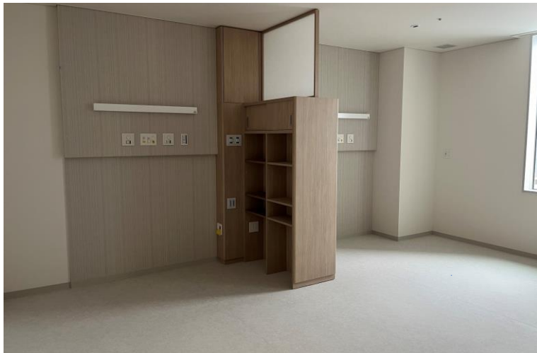
写真⑪(内装工事 4床室内装施工状況)
