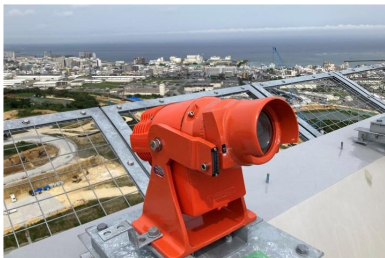
写真⑮(電気工事 屋上ヘリポート照明取付状況)
