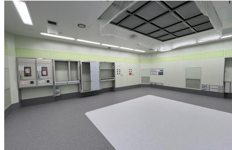
写真⑫ (内装工事 手術室仕上施工状況)
