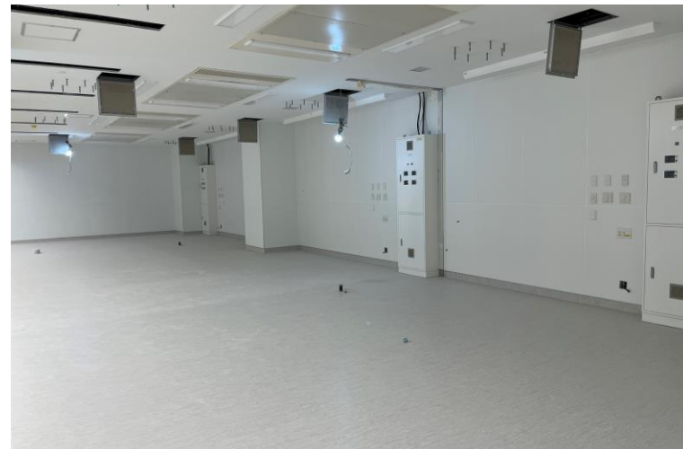
写真⑫ (内装工事 ICU仕上施工状況)
