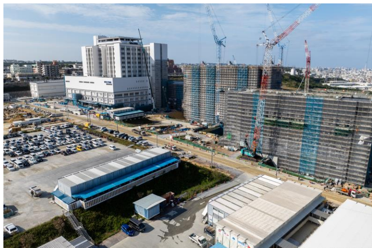
写真⑨(北東側)
