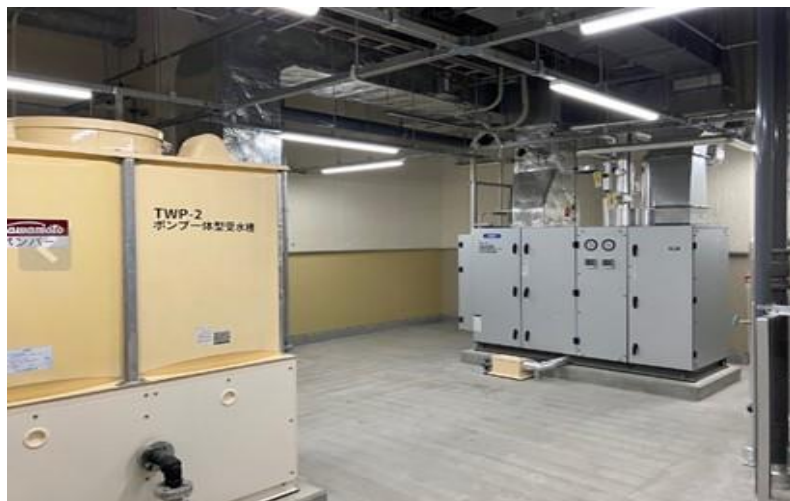
写真⑬(機械工事 機械室施工状況)
