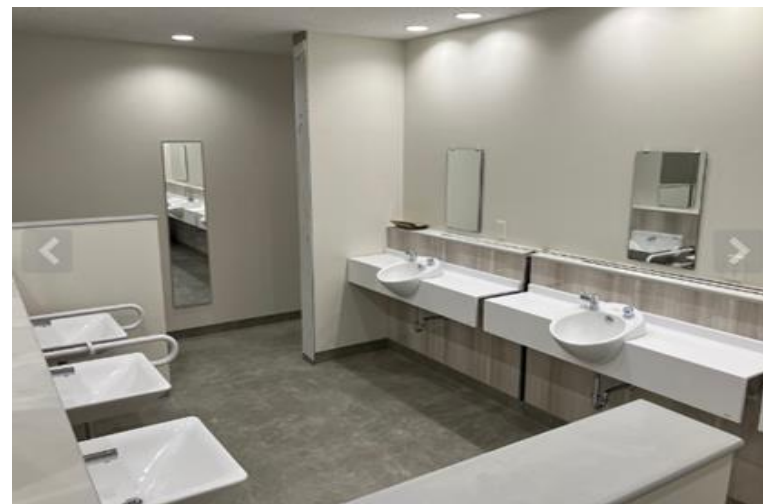
写真⑭(機械工事 便所 衛生器具取付状況)
