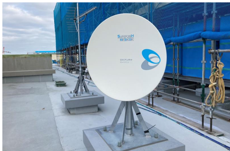
写真⑮(電気工事 テレビアンテナ設置状況 (屋上))
