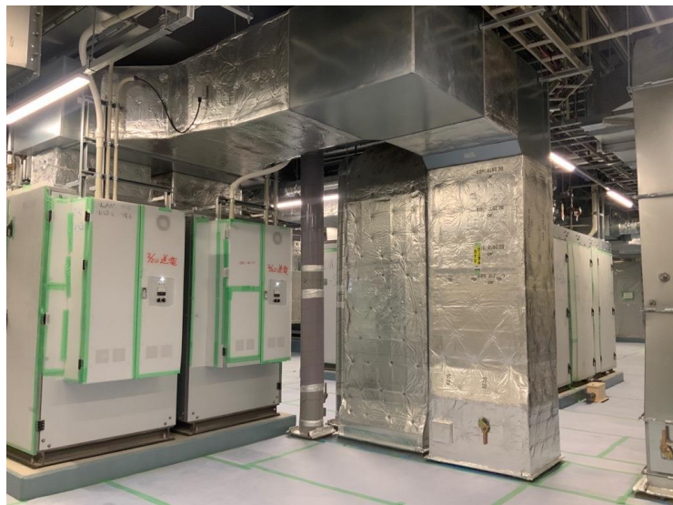
写真⑬(機械工事 機械室施工状況)
