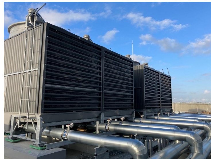
写真⑭(機械工事 屋上 冷却塔周り施工状況)
