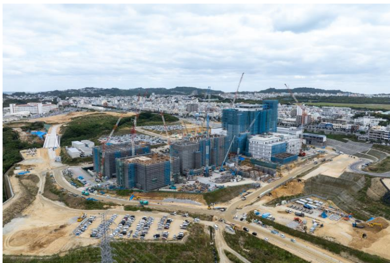
写真⑦(北西側)
