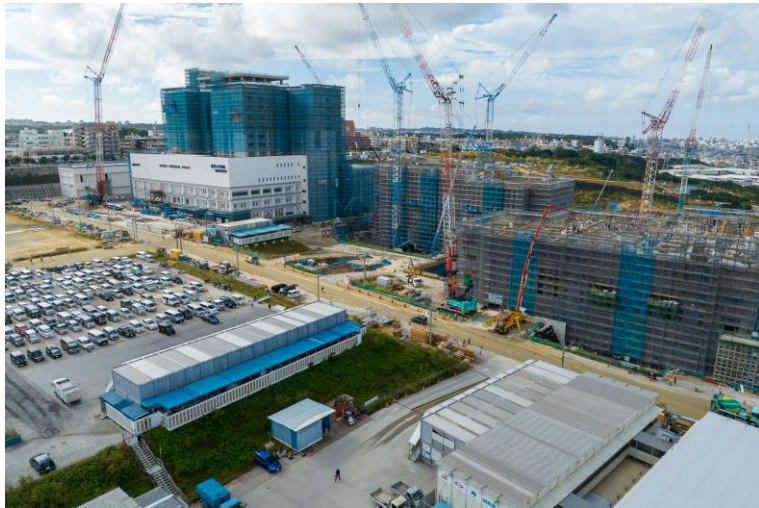
写真⑨(北東側)
